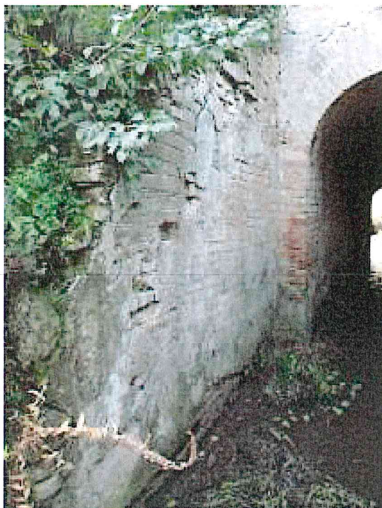
FOTO 5. Ziduri întoarse și boltă degradate
