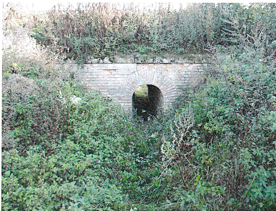
FOTO 1. Vedere dreapta podeţ boltit
