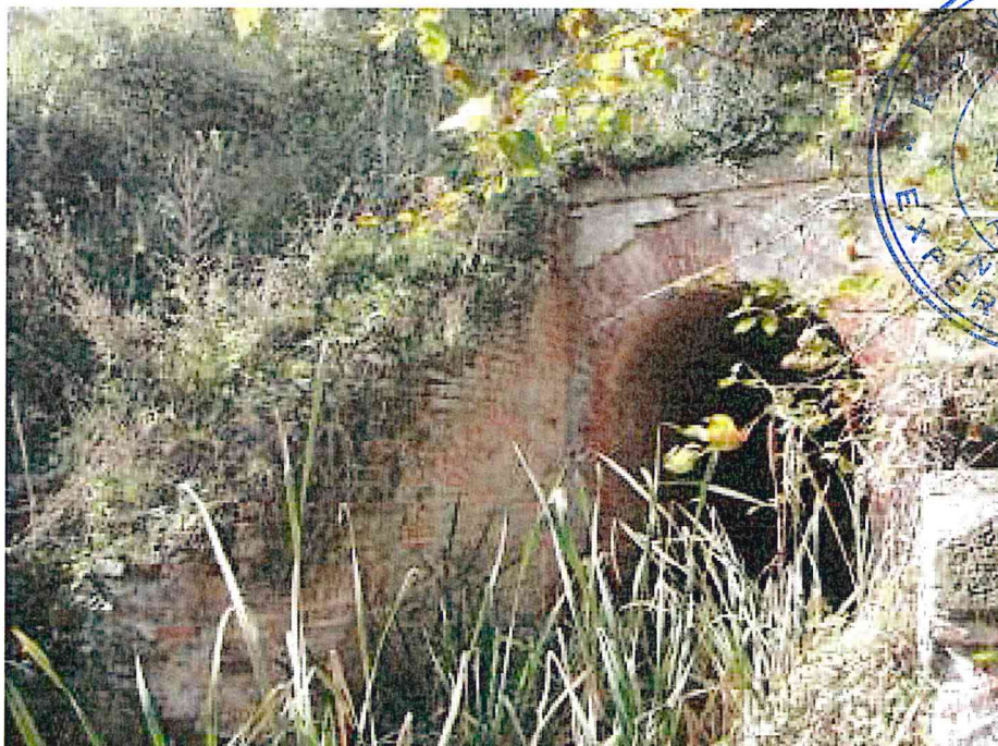
FOTO 2. Ziduri cărămidă stângă
