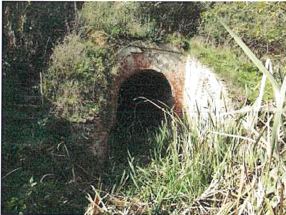
FOTO 1. Vedere stânga podeț boltit
