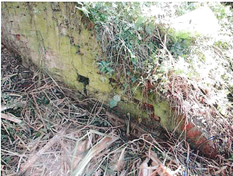
FOTO 6. Zid cărămidă dreapta cu dislocări
