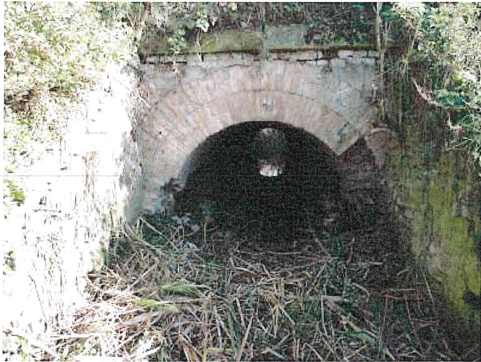
FOTO 1. Vedere amonte podeț boltit
