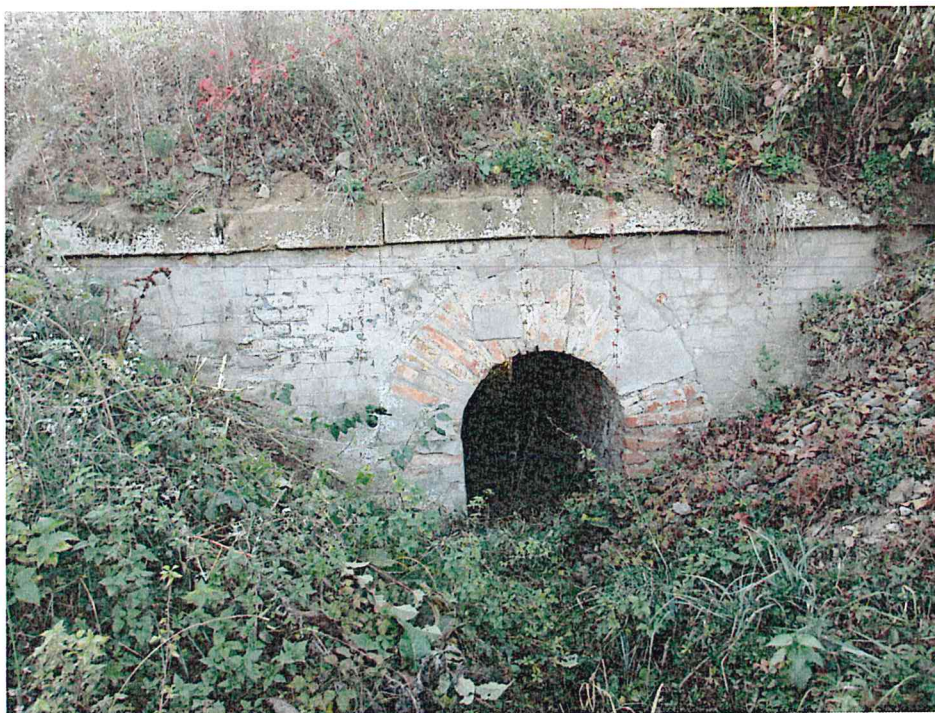
FOTO 1. Vedere dreapta podet boltit
