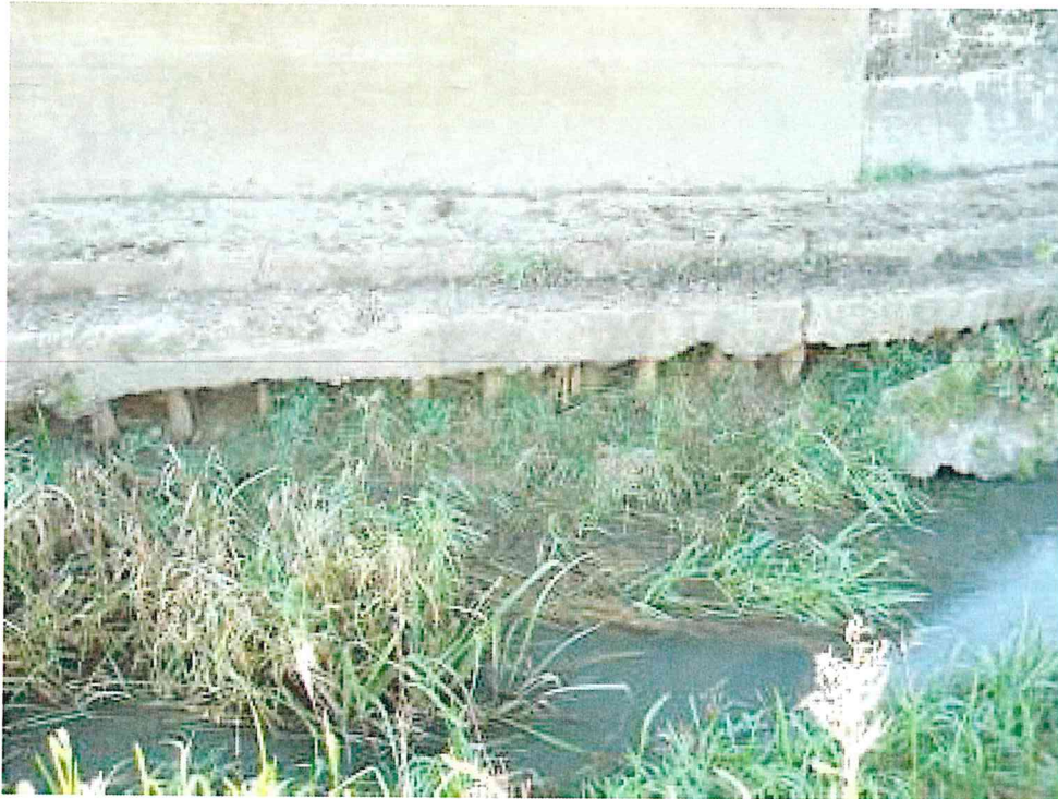
FOTO 13. Radier protecție pe piloți de lemn
