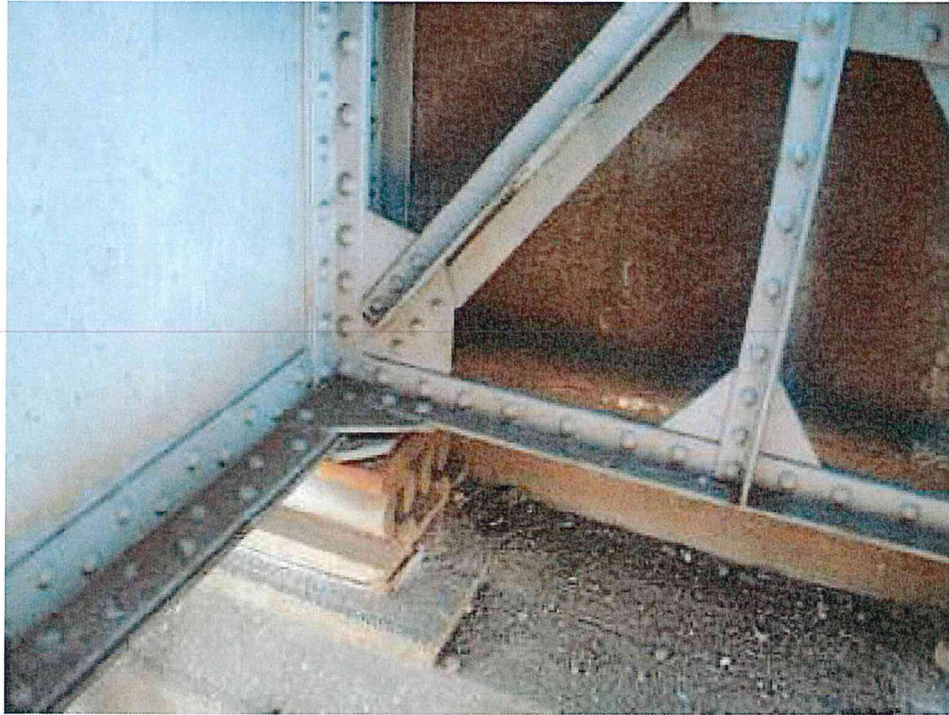
FOTO 11. Talpa inferioară și aparat de reazem
