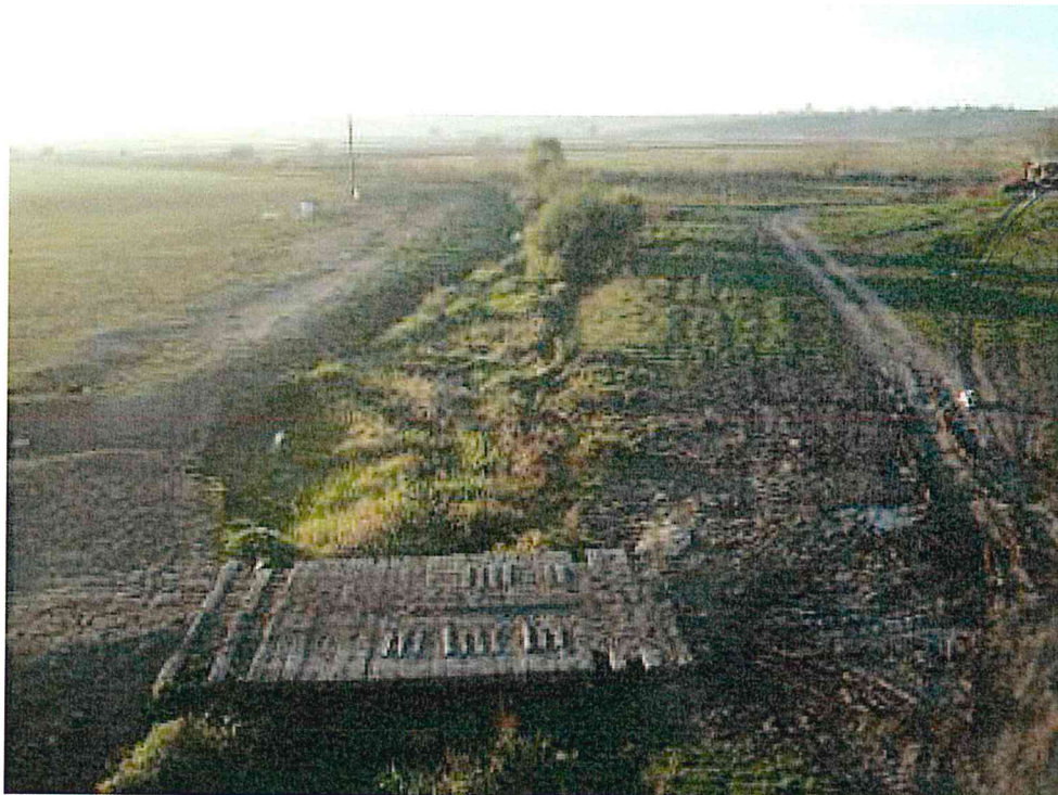
FOTO 14. Podeț din traverse de beton
