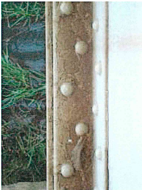
FOTO 9. Exfoliere protecție anticorozivă
