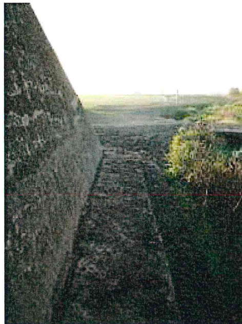
FOTO 5. Albie pod și protecție culee
