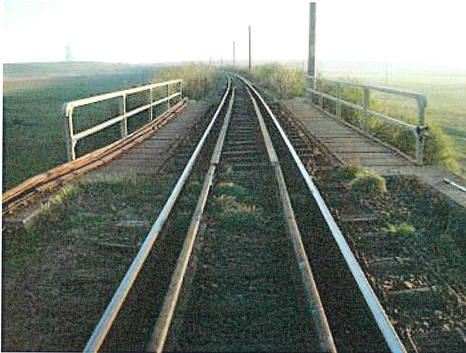
FOTO 1. Vedere sus pod
