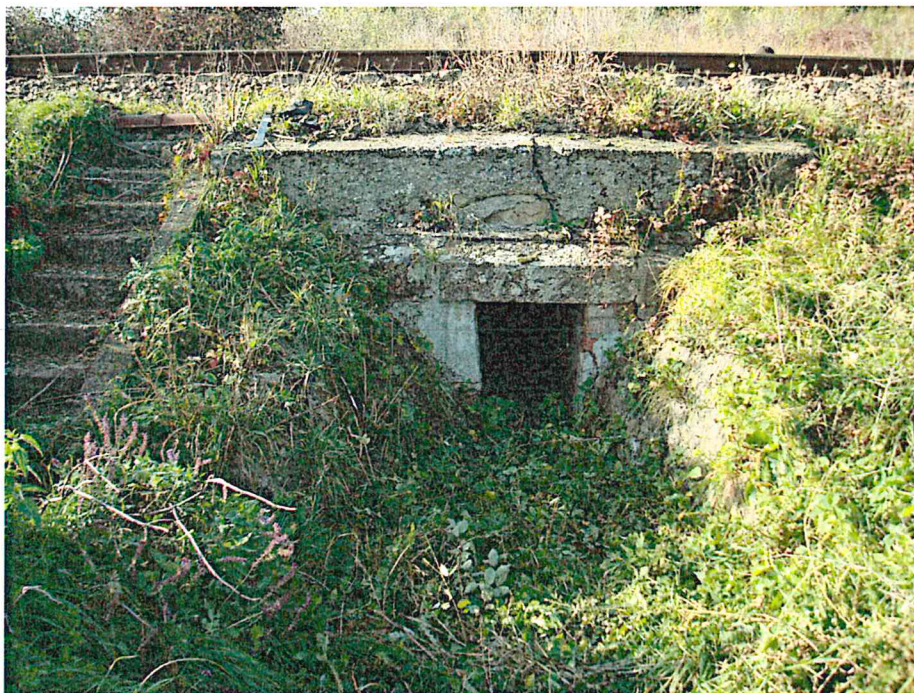
FOTO 4. Vedere aval podeţ dalat
