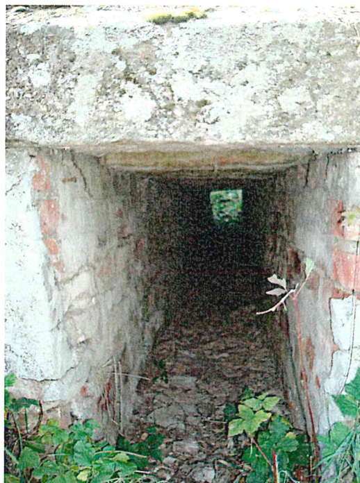
FOTO 3. Pereu piatră degradat
