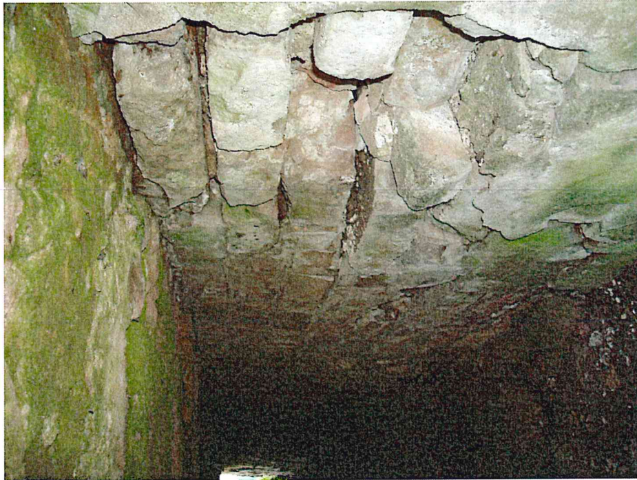
FOTO 6. Degradări majore interior podeț
