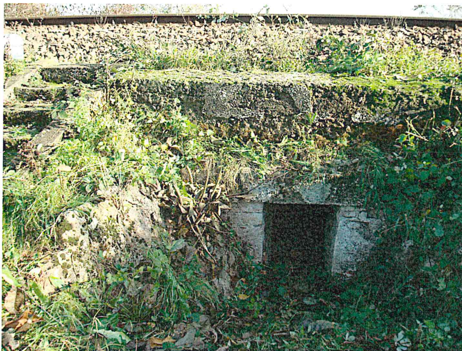
FOTO 1. Vedere amonte podeț dalat
