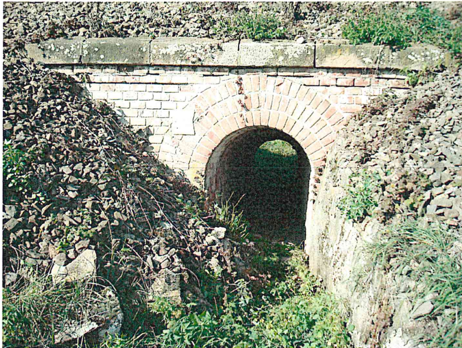
FOTO 6. Vedere dreapta podeț boltit
