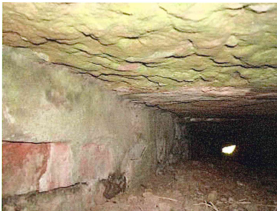
FOTO 5. Interior podeţ dalat obturat şi dală degradată
