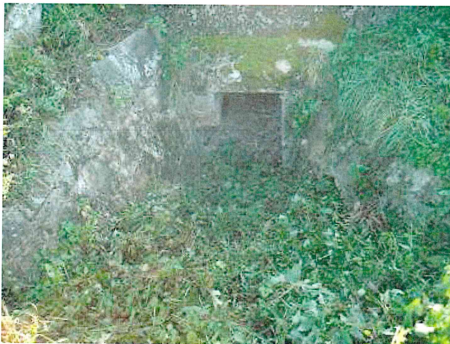
FOTO 1. Vedere amonte podeţ dalat
