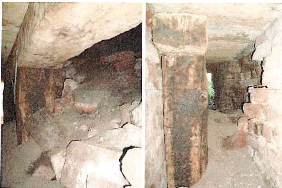
FOTO 4 și FOTO 5. Sprjinire zonă prăbușită
