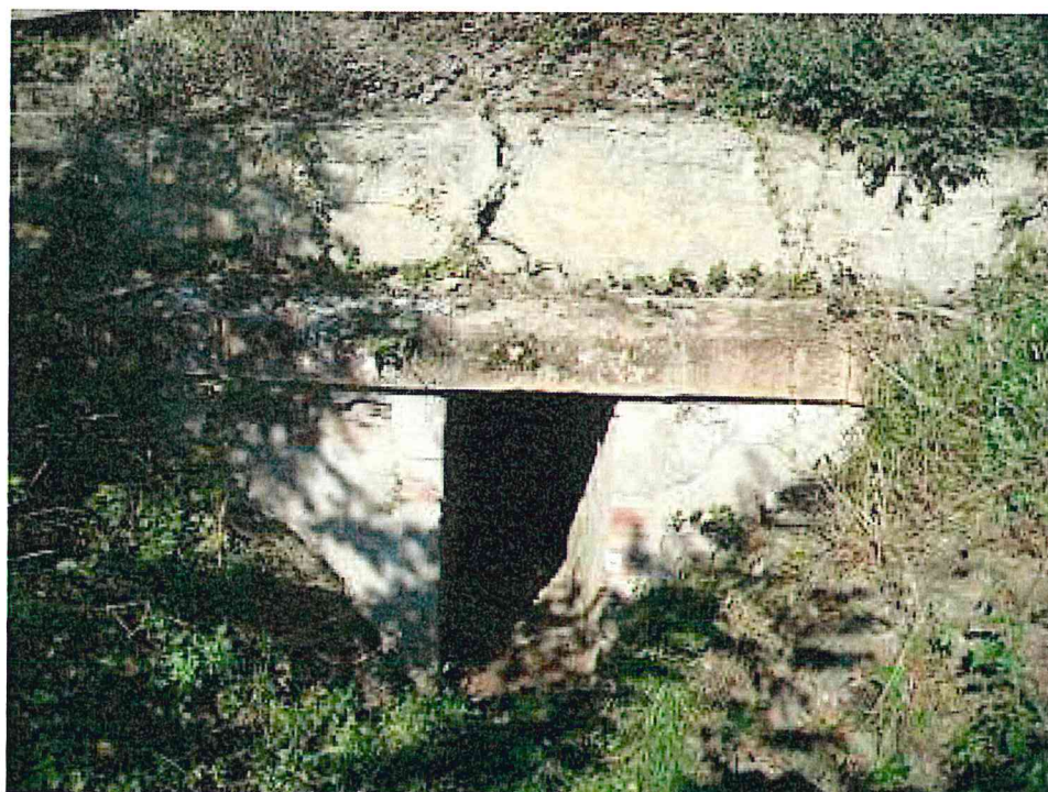
FOTO 6. Vedere aval podeț dalat
