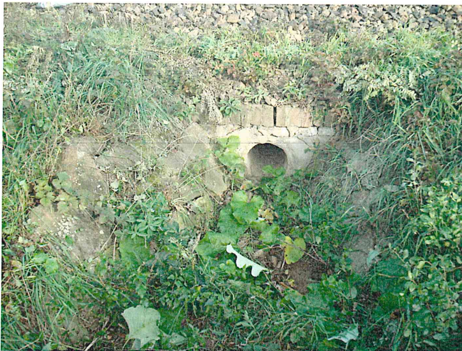
FOTO 1. Vedere amonte podeț tubular
