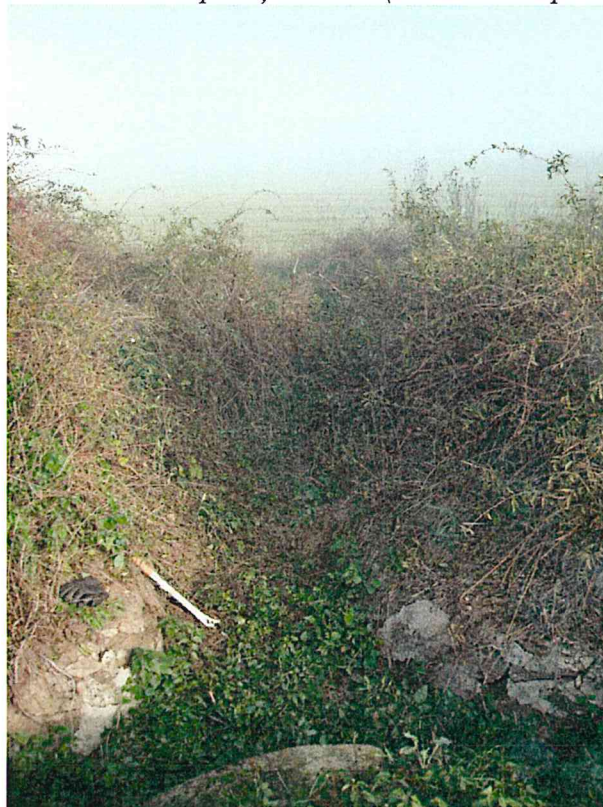
FOTO 4. Albie amonte cu perei degradat
