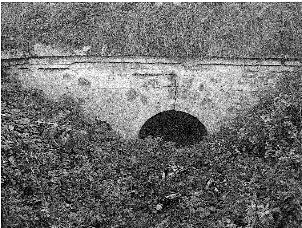
FOTO 2. Vedere dreapta podeț boltit
