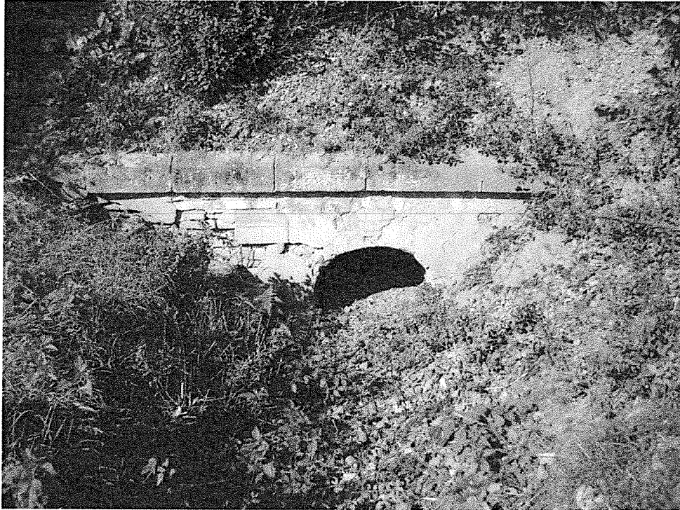
FOTO 1. Vedere dreapta podeț boltit
