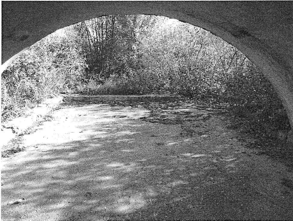
FOTO 5. Vedere spre amonte
