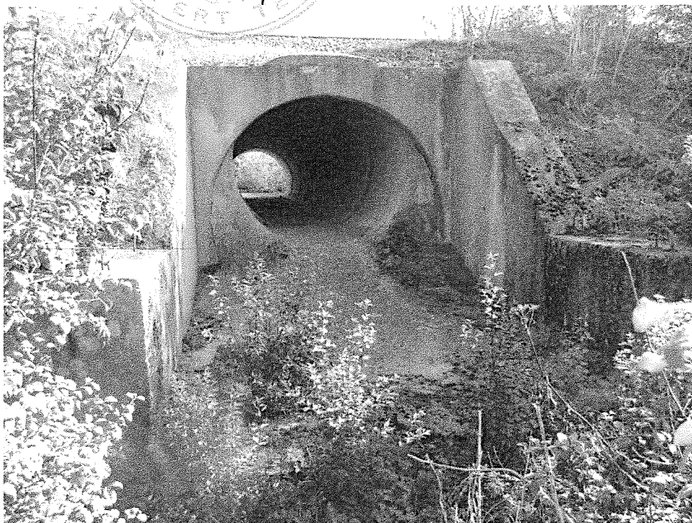
FOTO 1. Vedere aval podeț forat
