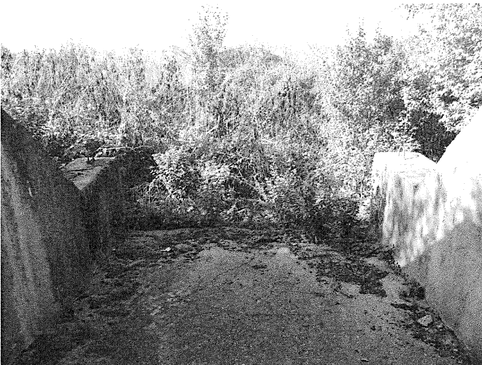
FOTO 6. Vedere spre aval
