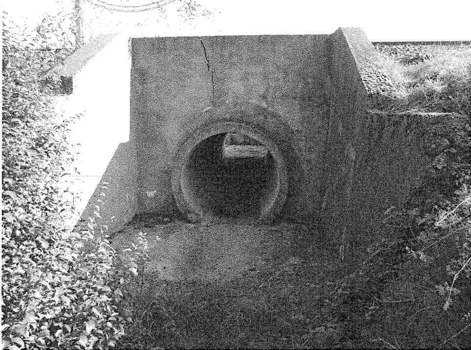
FOTO 1. Vedere aval podeț forat
