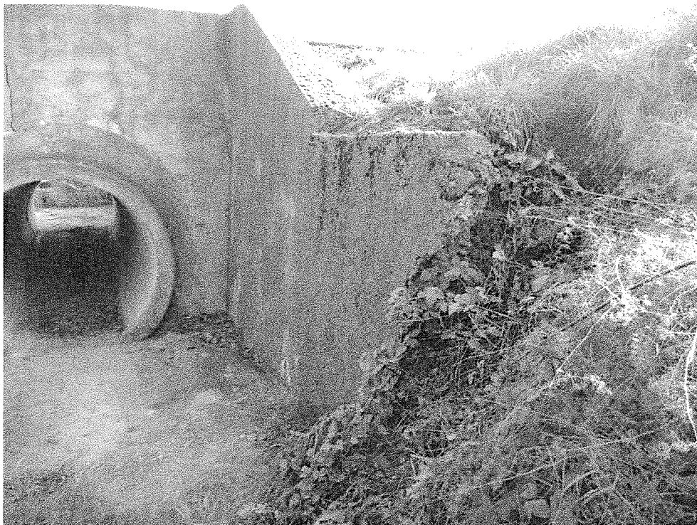
FOTO 2. Vedere aripă dreapta aval
