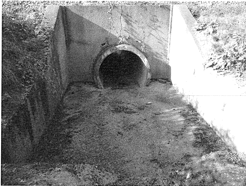
FOTO 5. Timpan amonte și camera de cădere
