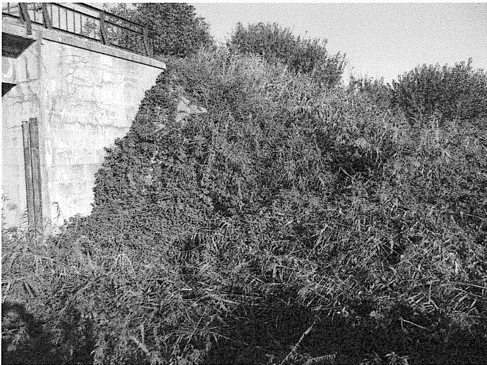
FOTO 4. Vedere albie stânga și sfert de con înierbat
