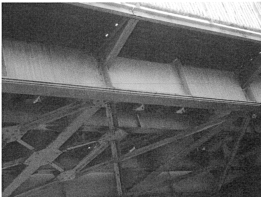
FOTO 3. Prinderi realizate cu nituri
