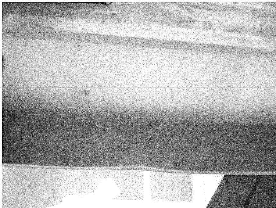
FOTO 7. Torsionare a tălpii inferioare a lonjeronilor
