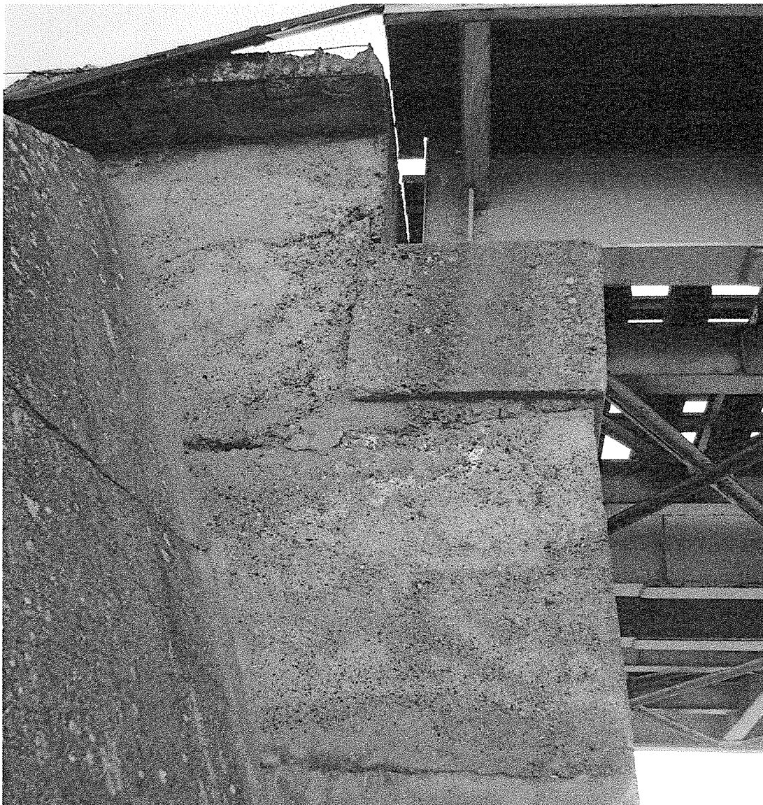
FOTO 9. Armături la vedere și beton degradat la consolele zidului întors
