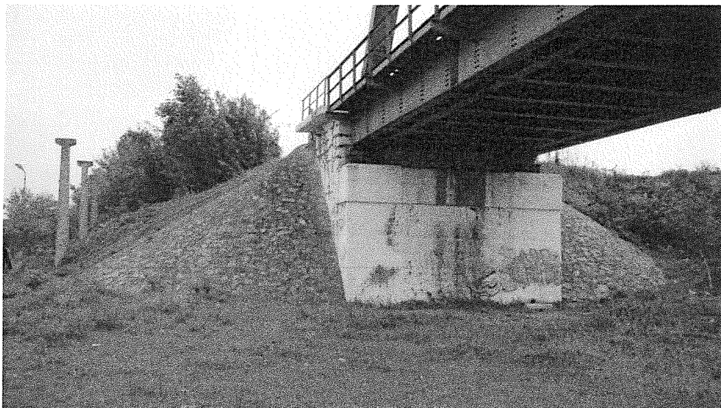
FOTO 20. Vedere culee Arad
