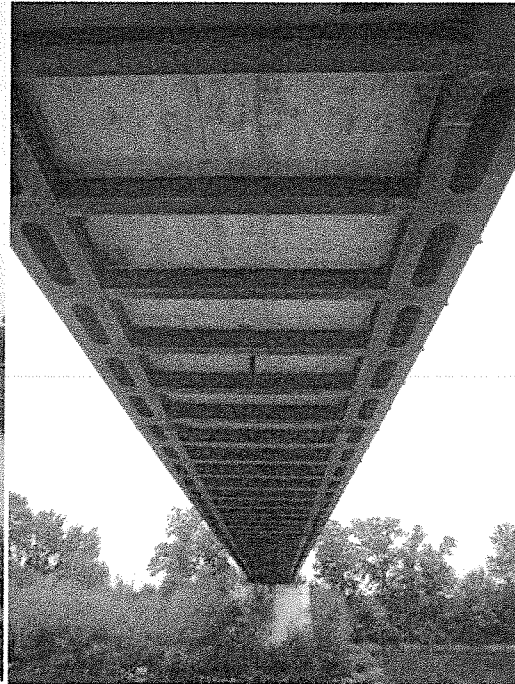
FOTO 2. Vedere de sub pod
