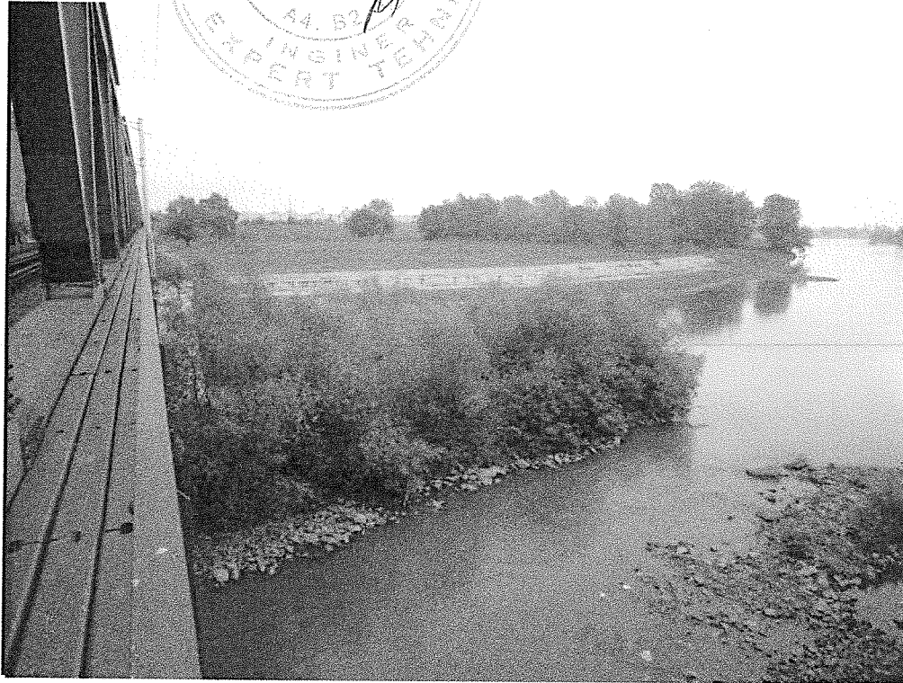
FOTO 24. Vedere albie amonte
