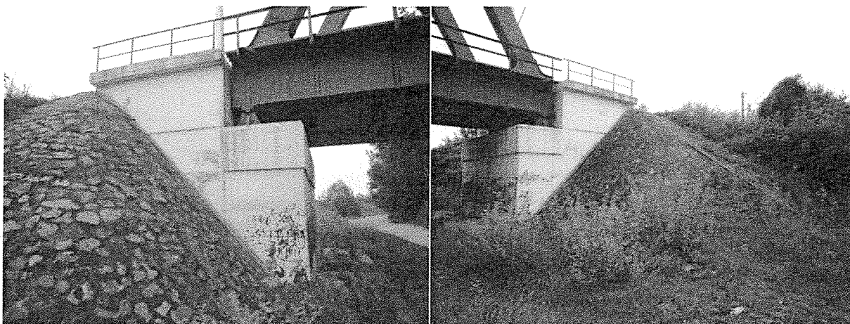
FOTO 8. Vedere dreapta culee și sfert de con
