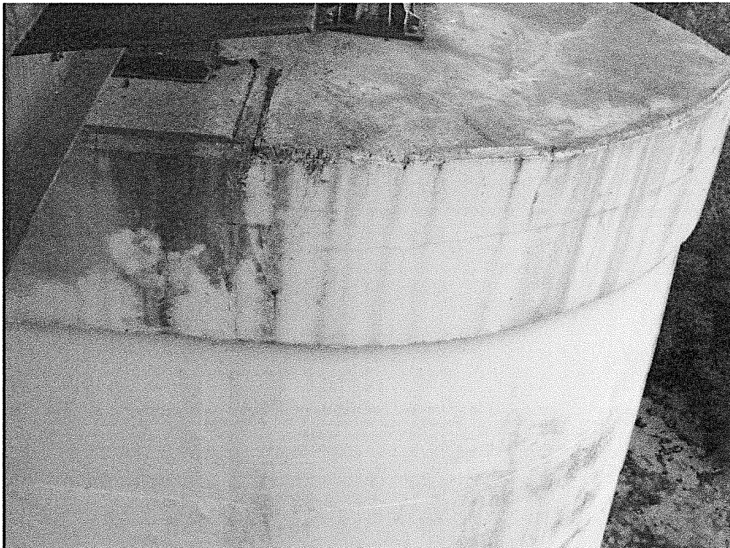
FOTO 12. Vedere laterală pila 1
