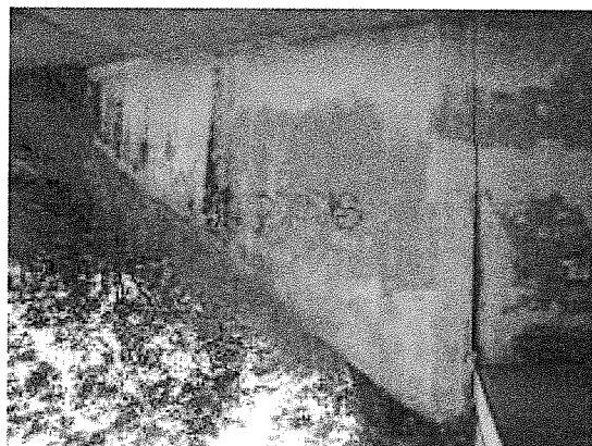
FOTO 5 și 6. Defecte beton aripi și rosturi
