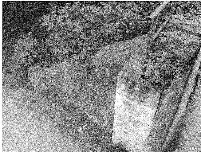
FOTO 7. Aripă beton și parapet
