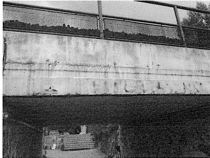
FOTO 4. Defecte beton suprastructură
