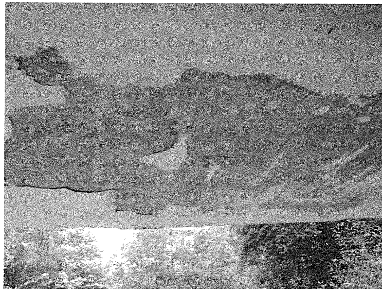
FOTO 6. Beton degradat dală
