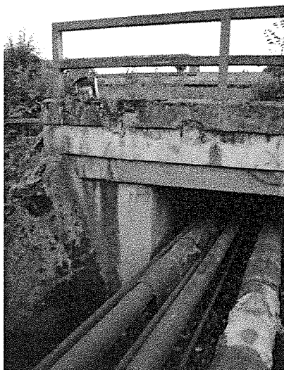
FOTO 3 și 4. Defecte beton la timpan și aripi
