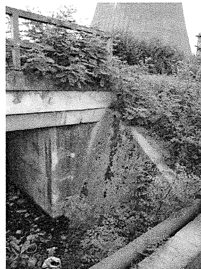
FOTO 3 și 4. Defecte beton la timpan și aripi
