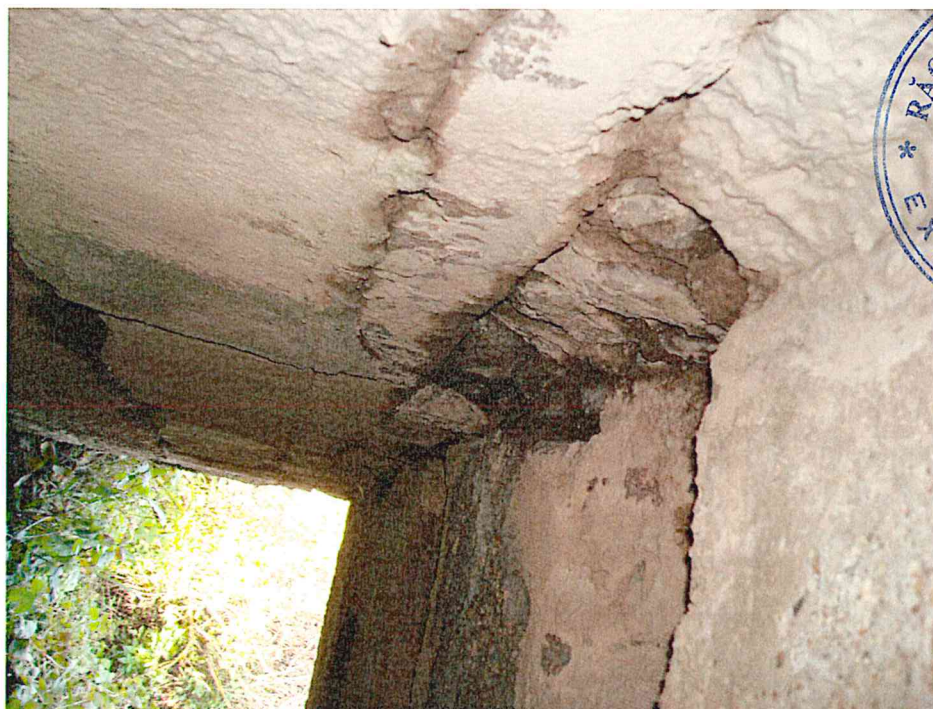
FOTO 7. Infiltrații și degradări moloane piatră
