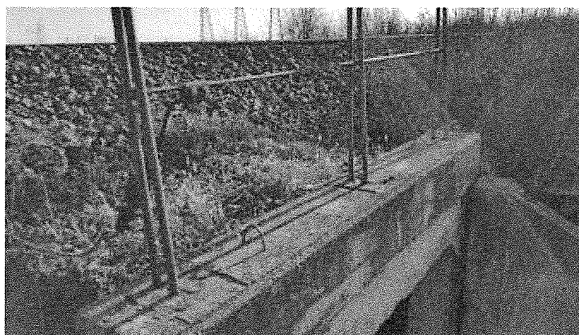
FOTO 4. Parapete metalic din bare de oțel beton
