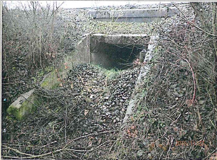
Foto nr.21-Podet km 536+210
