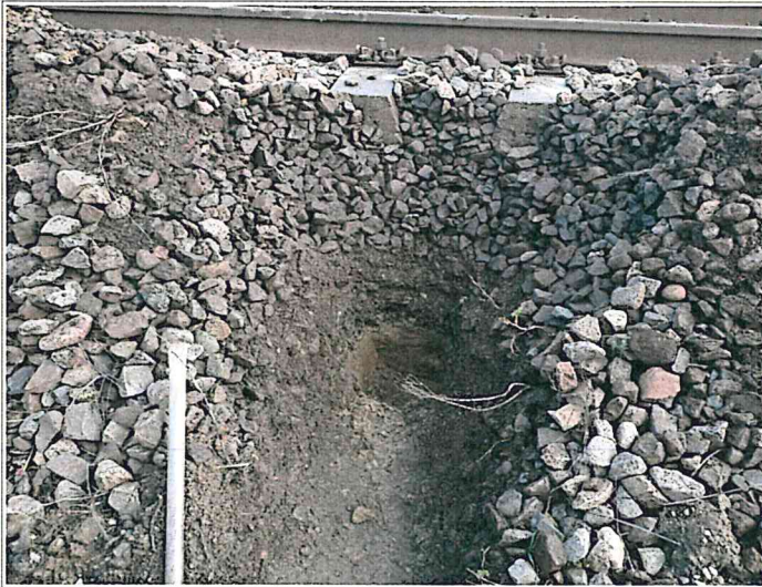
Foto nr.13-Dezvelire la cap de traversa
