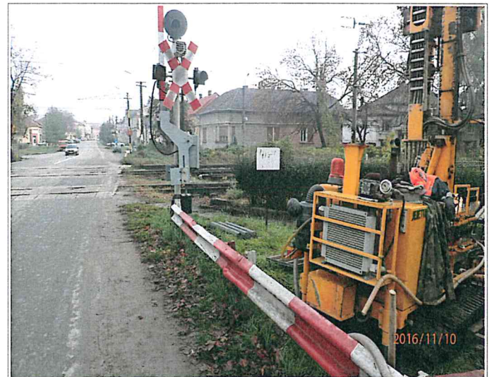
Foto nr.28- Pozitionare foraj km 515+604
