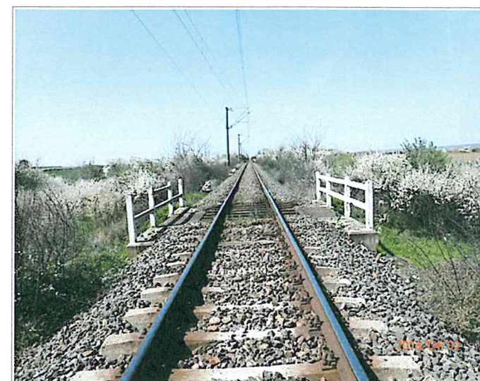
Foto nr.12- Podet km 544+750
