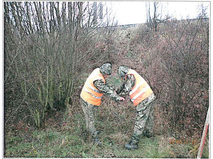
Foto nr.20-Executie foraj la km 535+400
