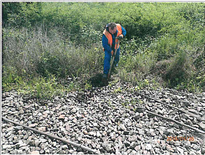
Foto nr.1-Executie sondaj
