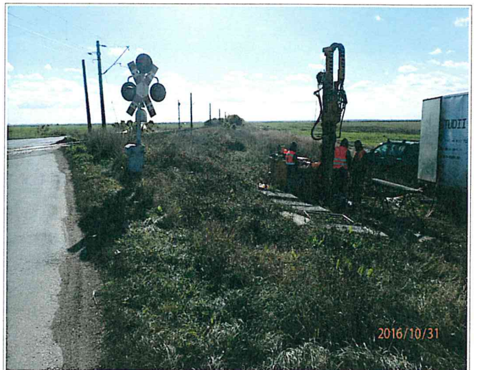
Foto nr.24- Executie foraj km 18+714
