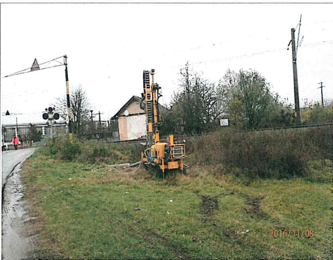
Foto nr.29-Executie foraj km 513+604
