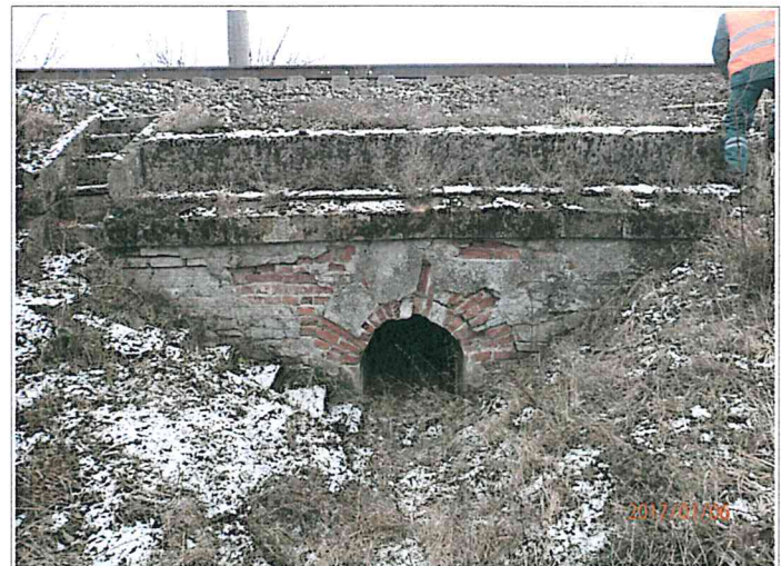
Foto nr.34- Podet km 38+650
