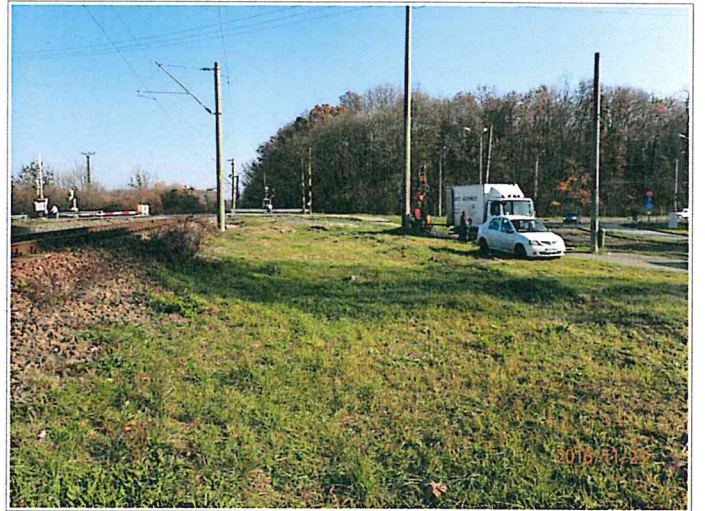
Foto nr.22- Executie foraj km 569+260
