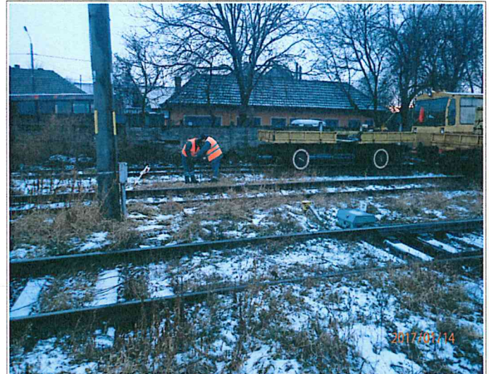
Foto nr.32- Executie foraj Statia Lugoj
