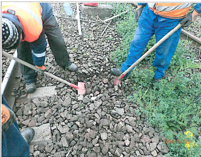
Foto nr.5-Executie dezvelire cap traversa
