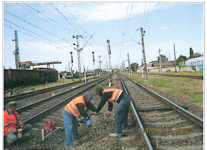
Foto nr.4- Executie foraj Statia Timisoara Nord
