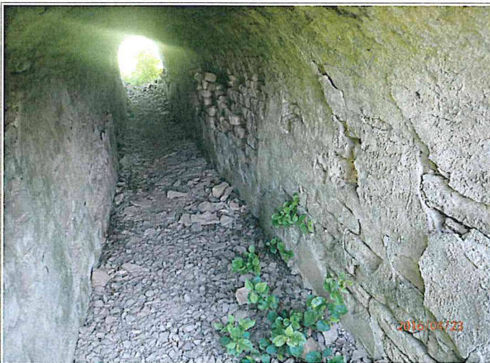
Foto nr.15-Degradari ale podetului km 21+262
