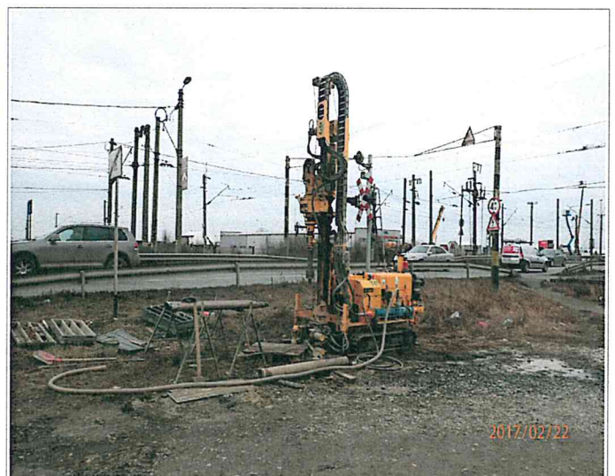
Foto nr.42- Pozitionare foraj varianta km 5+317
