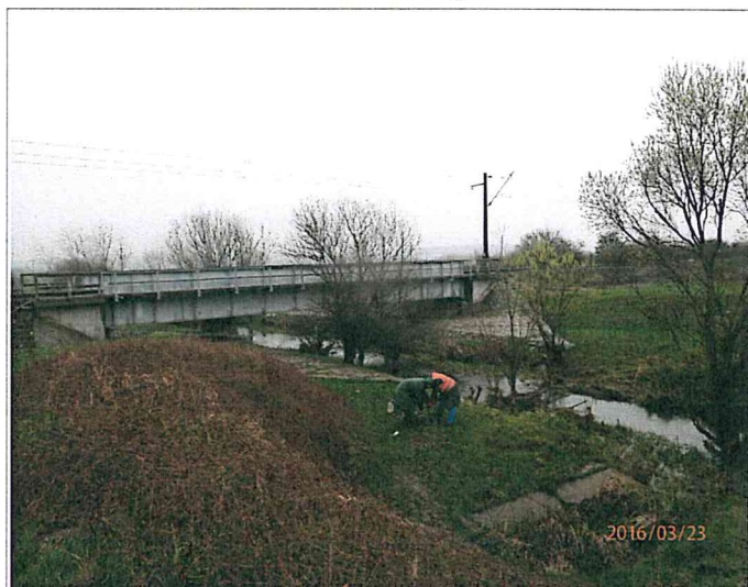
Foto nr.10- Executie foraj pozitia km 512+627
