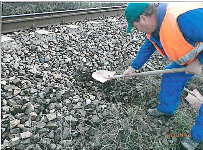
Foto nr.3-Executie in teren a unei dezveliri la cap traversa
