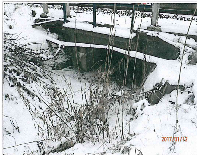
Foto nr.35- Podet km 502+843
