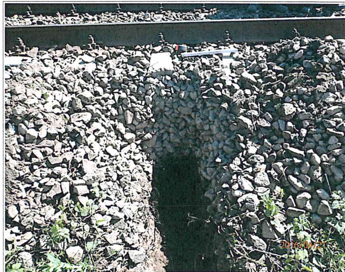
Foto nr.8- Dezvelire cap traversa
