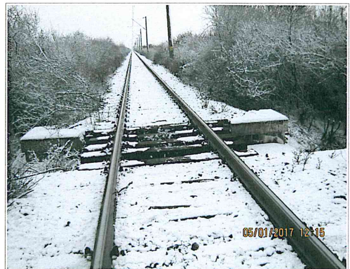
Foto nr.36-Podet km 548+347
