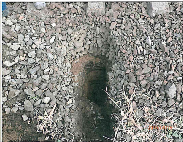
Foto nr.7-Dezvelire la cap traversa
