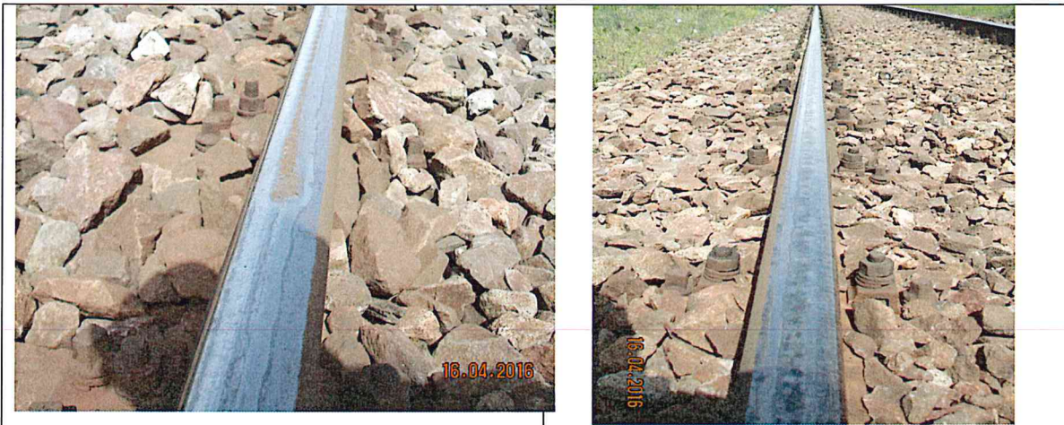
Exfolieri și știrbituri pe suprafața de rulare
