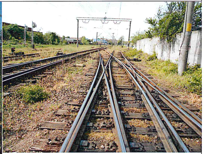
Prism de piatra sparta colmatat pana la NST, acoperit de vegetatie
