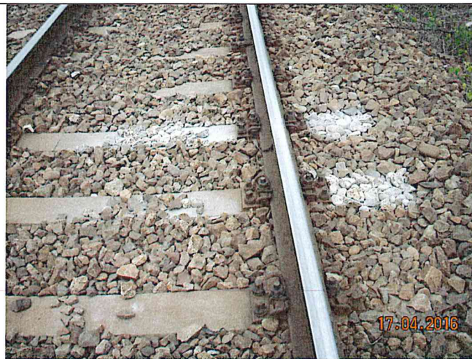
Lasaturi oarbe. Lipsa umăr de piatra sparta. Piatră cursă pe taluz.
