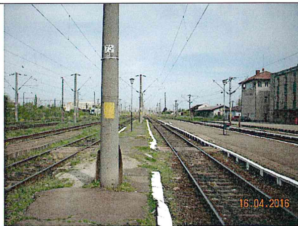
Km 476+350 vedere spre cap Y stație peroane degradate, amenajările acceselor la peroane nu sunt conforme cu normele în vigoare
