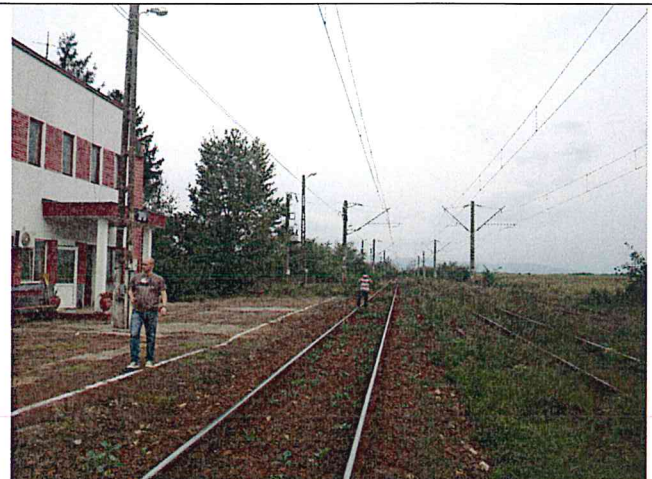
Km 509+200 – lipsa peroane, prismul de piatra sparta colmatat si acoperit de vegetatie
