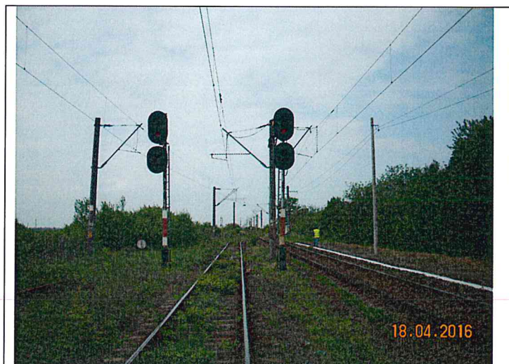
Km 528+700 vedere spre capul Y al stației – vegetație în prismul de piatră spartă, peroane degradate
