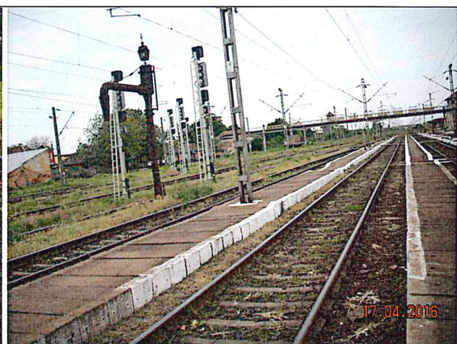
Km 515+550 – dimensiunile peroanelor nu respecta cerintele normelor in vigoare, prezenta vegetatiei in prisma de piatra sparta
