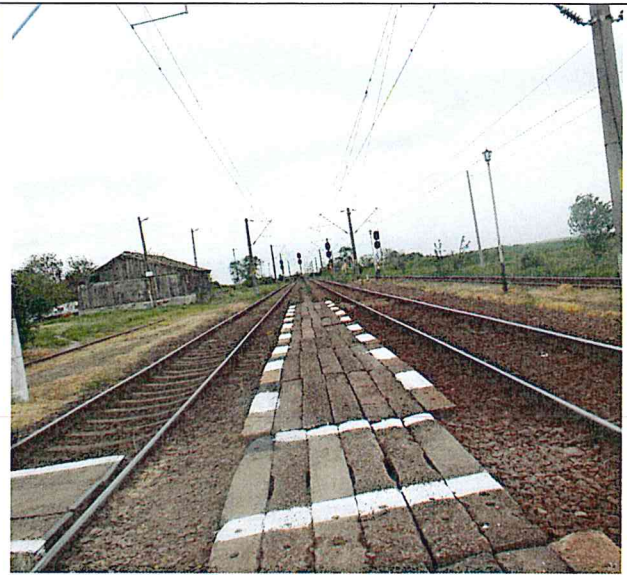
Peroane din traverse din beton
