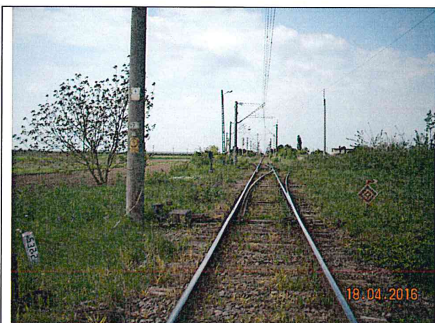
Km 532+200 vedere spre capul Y – traverse de lemn crăpate și fisurate, lipsa santurilor
