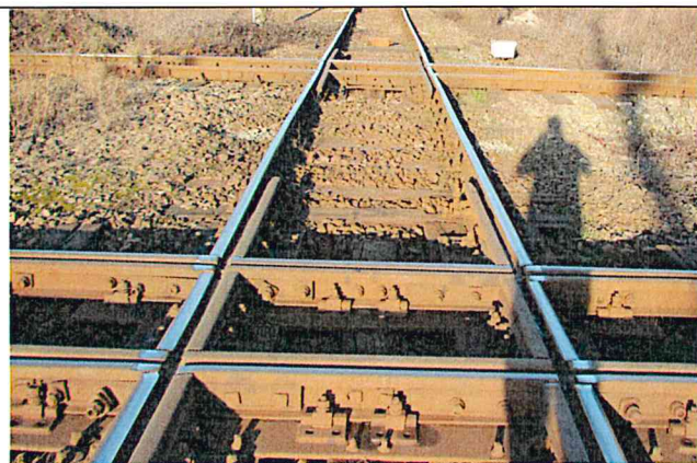
Intersecţie linie CF – linie tramvai
