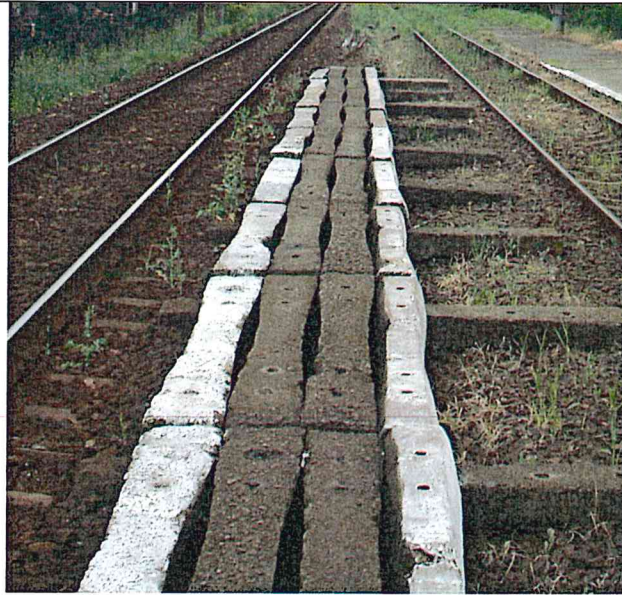
Peroane din traverse din beton
