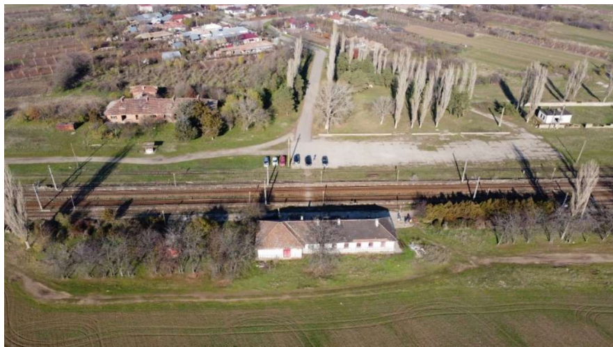
Figura 11. Vedere aeriană Hm Radomirești
