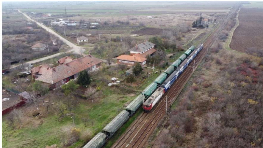
Figura 37. Vedere aeriană Stația Jianca
