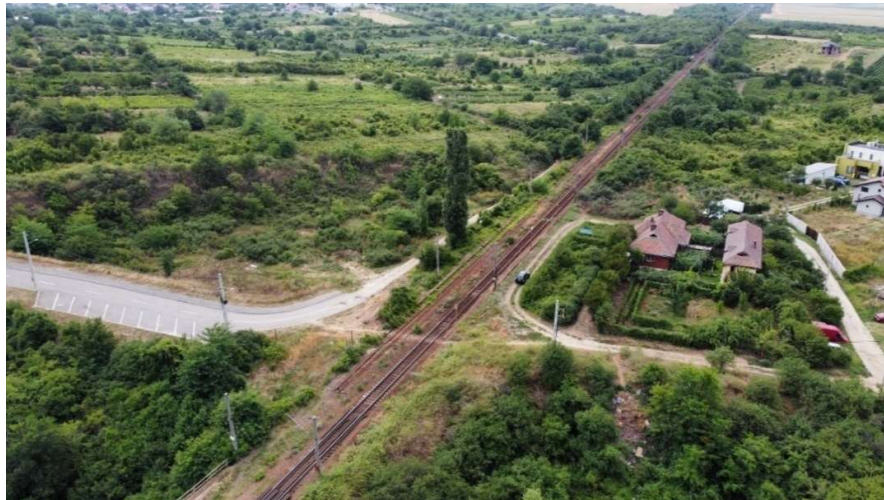
Figura 51. Vedere aeriană halta Viaduct Cârcea
