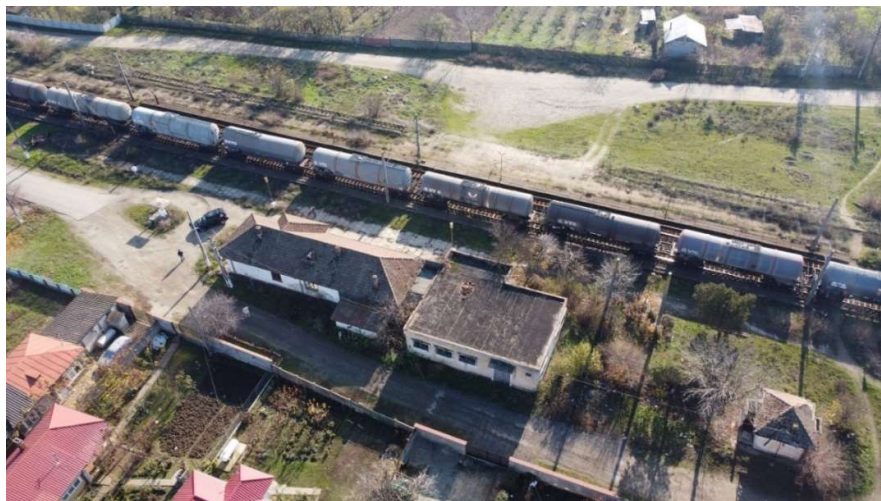
Figura 19. Vedere aeriană H Stoenesti
