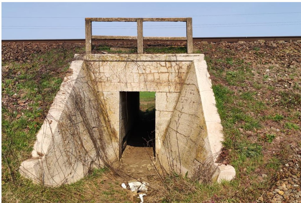
Podet km 55+997 – Dală din beton armat
