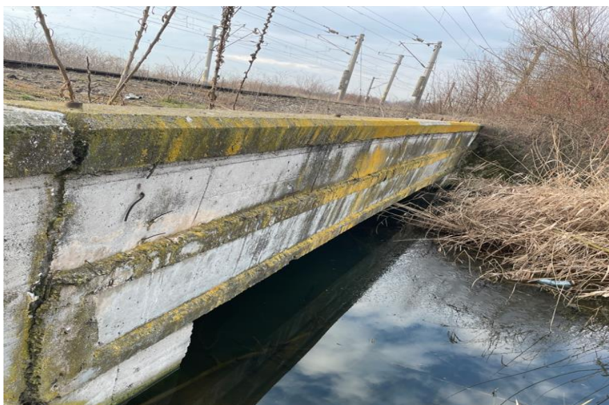
Pod km 8+185 – Dală din beton armat
