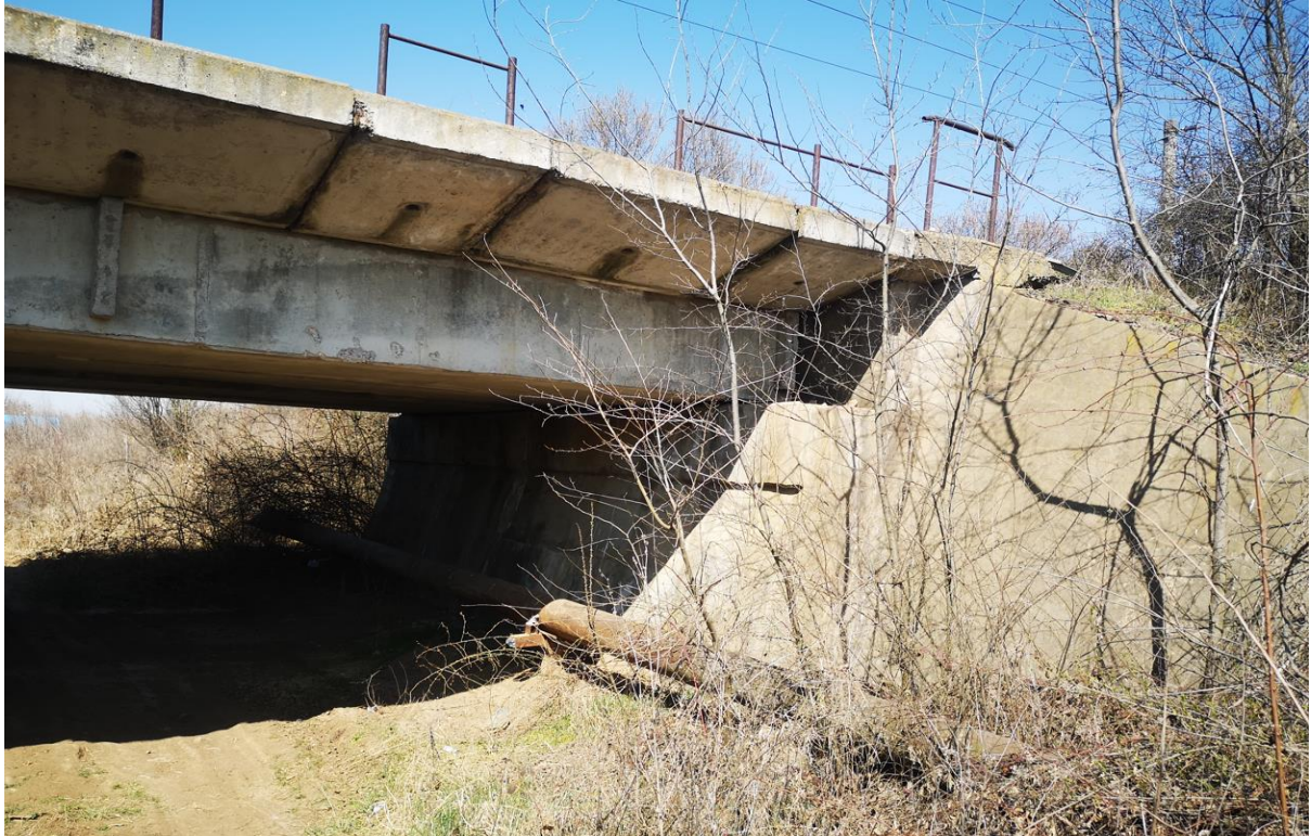
Pod km 42+917 – Grindă din beton armat
