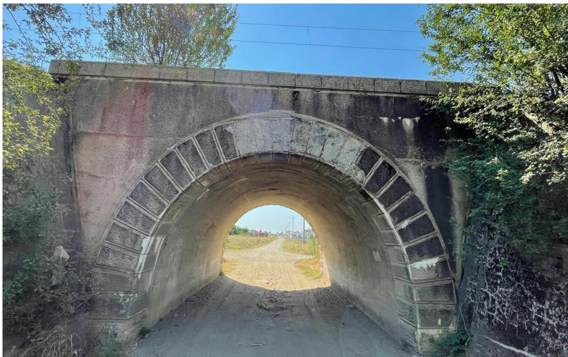
Pod km 17+283 – Boltă din beton armat
