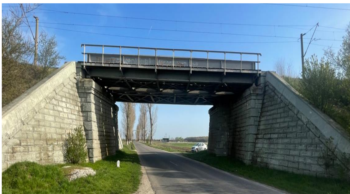
Pod km 74+557 – Grindă inimă plină cale jos
