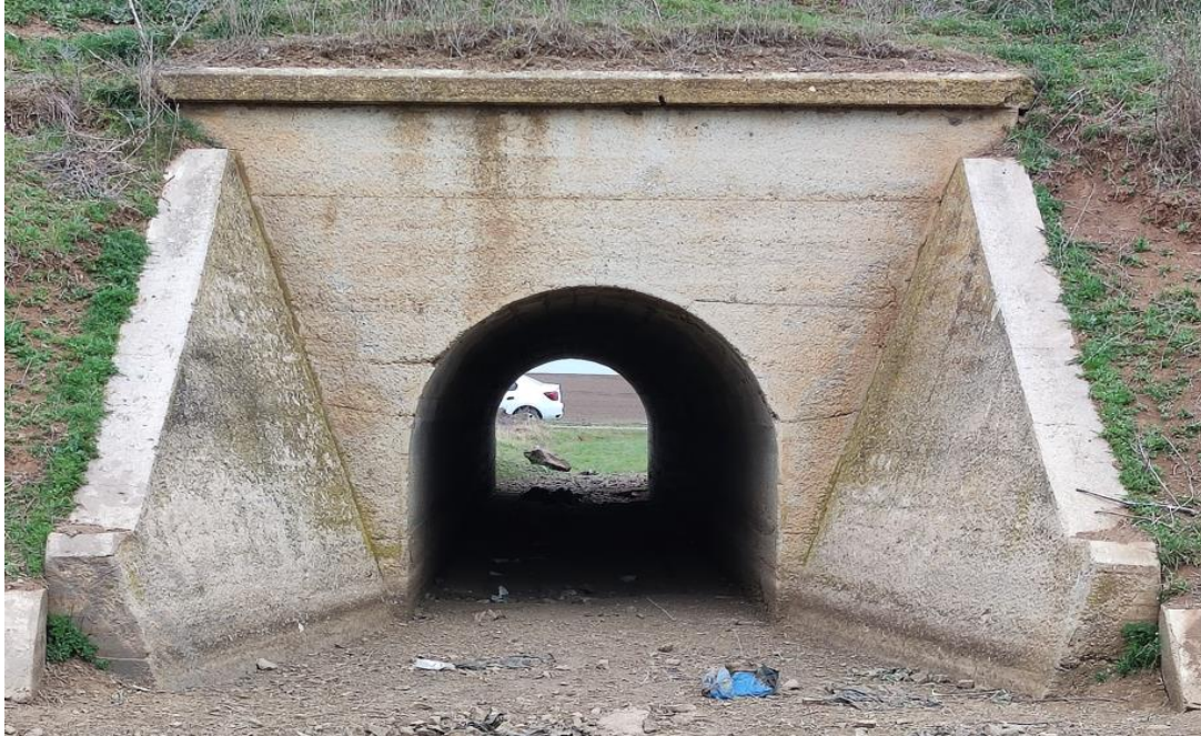
Podet km 69+657 – Dală din beton armat
