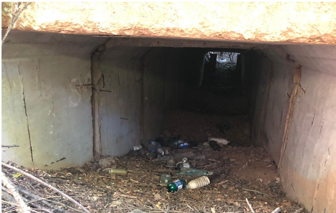
Podet km 31+137 – Cadru din beton
