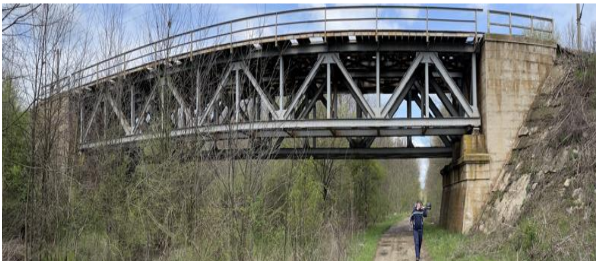
Pod km 97+610 – Grindă cu zăbrele cale sus
