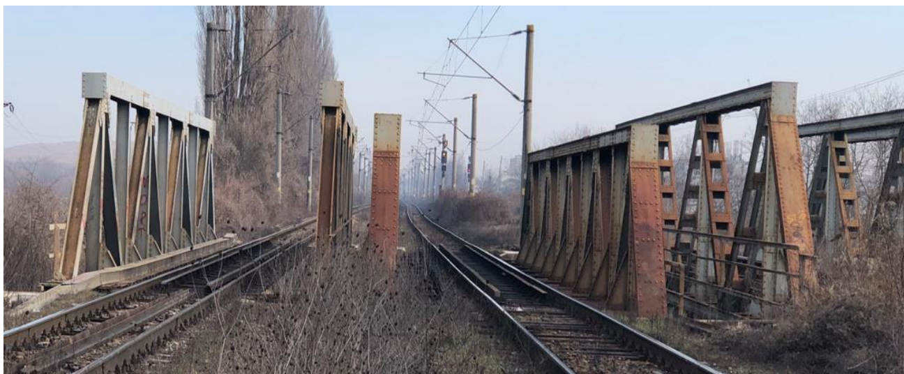
Pod km 10+283 – Grindă cu zăbrele cale jos
