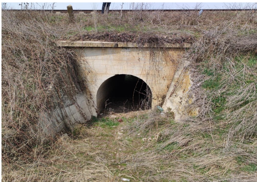
Podul km ex. 64+100 – Podul colmatat cu vegetație, materiale din aluviuni și materiale rezultate din refacția căii
