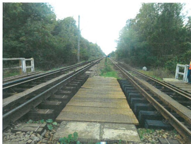
14. Vedere spre Timișoara Est, zona mediană dintre cele două poduri – vegetație crescută între linii.
