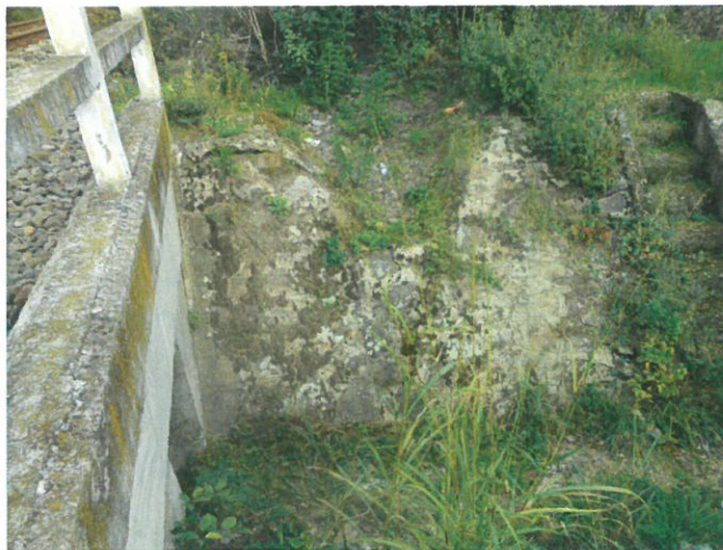
8. Vedere aval de podeț – degradări locale ale pereului din piatră, scara de acces de pe taluz este parțial degradată. Pereul din piatră este acoperit cu vegetație.
