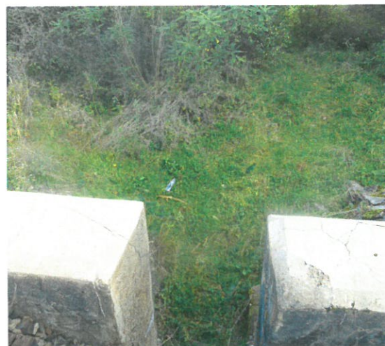
6. Vedere aval de podeț – fisuri, crăpături, exfolieri beton timpan. Albie neamenajată, vegetație crescută în albie, inclusiv arbuști și copaci.
