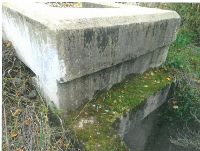
4. Timpan podeț amonte – culoare neuniformă, pete, muchii ciobite, exfolieri beton. Vegetație și mușchi crescute în zona podețului.
