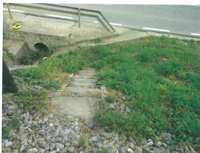
8. Vedere aval de podeț, racordare cu podețul de drum.
