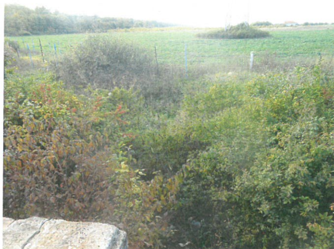
6. Vedere amonte de podeț – albie neamenajată, colmatată cu vegetație
