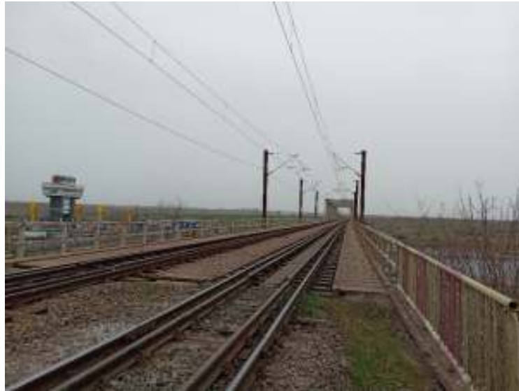
Figura 14. Pod peste ecluză km 233+341 (CFR) / km 233+337,74 (topo)
