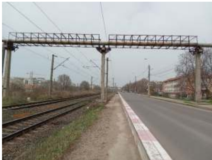
Figura 10. Estacadă km 228+099,85 (topo)
