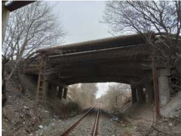
Figura 19. Supratraversare de conducte km 235+939,50 (topo)
