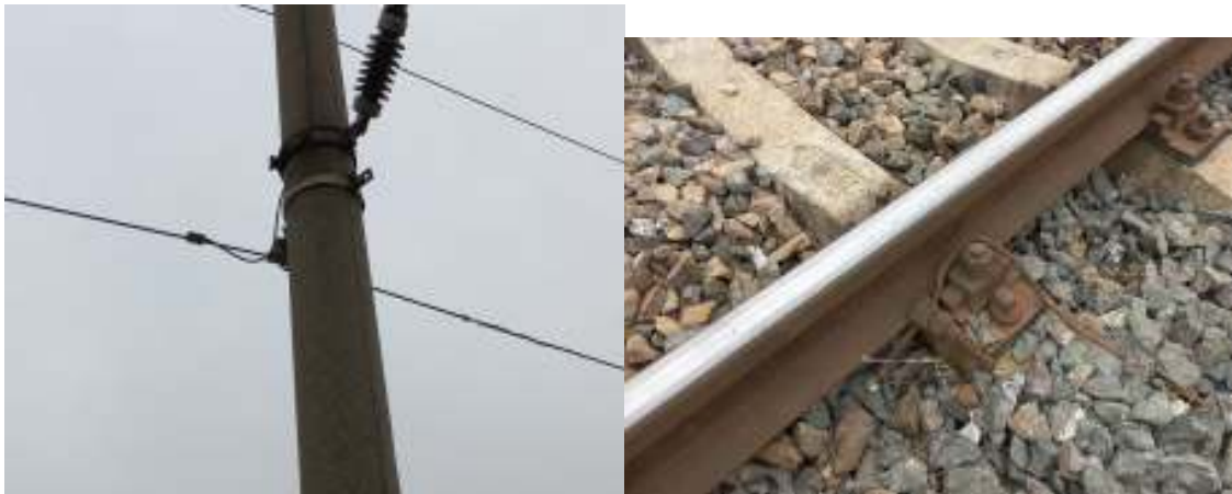
Figura 25. Protecții existente în cale
