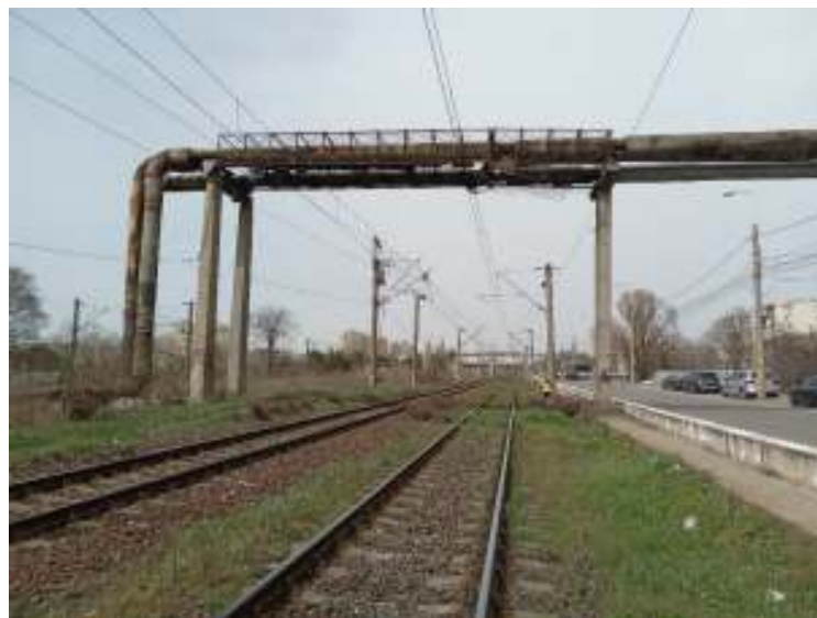
Figura 9. Estacadă km 227+771,89 (topo)
