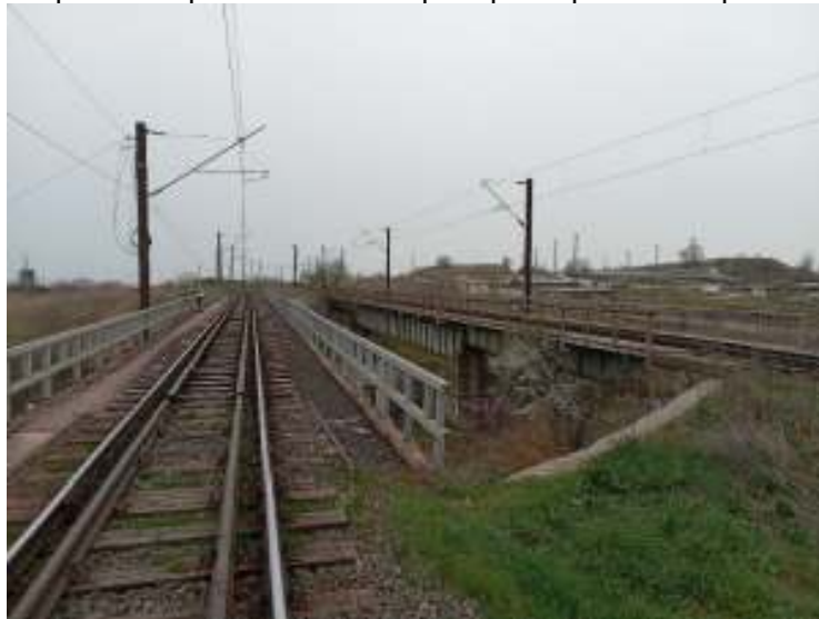
Figura 11. Pod de încrucișare km 228+895 (CFR) / km 228+981,36 (topo)
