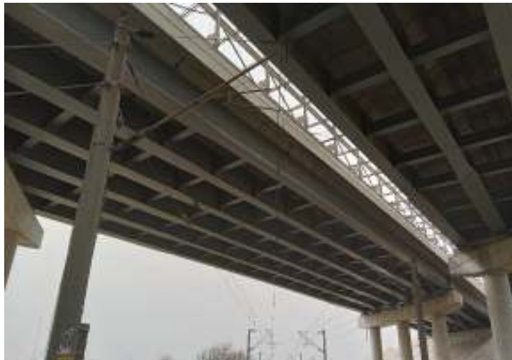
Figura 13. Pasaj superior (Autostrada A4) fir II km 232+053,33 (topo)
