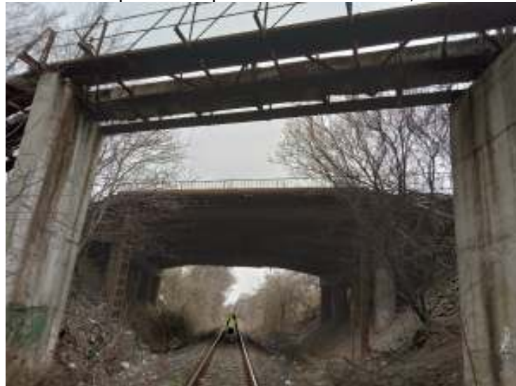
Figura 20. Supratraversare de conducte km 235+948,46 (topo)
