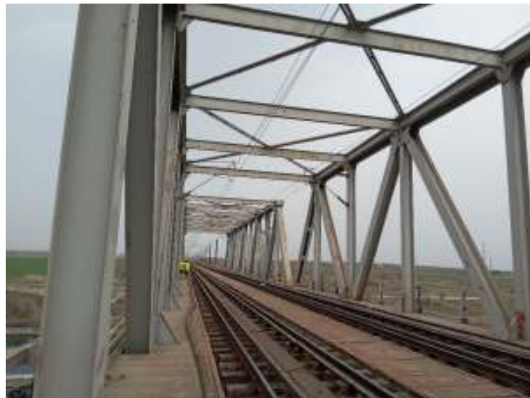
Figura 15. Pod peste ecluză km 233+341 (CFR) / km 233+337,74 (topo)
