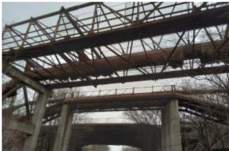
Figura 21. Supratraversare de conducte km 235+956,09 (topo)
