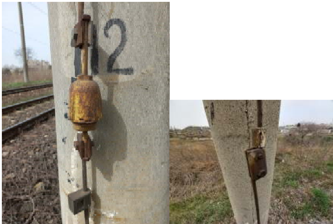
Figura 26. Protecții existente în cale
