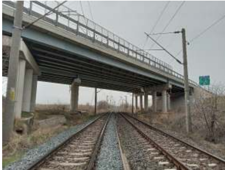
Figura 12. Pasaj superior (Autostrada A4) fir I km 232+053,33 (topo)
