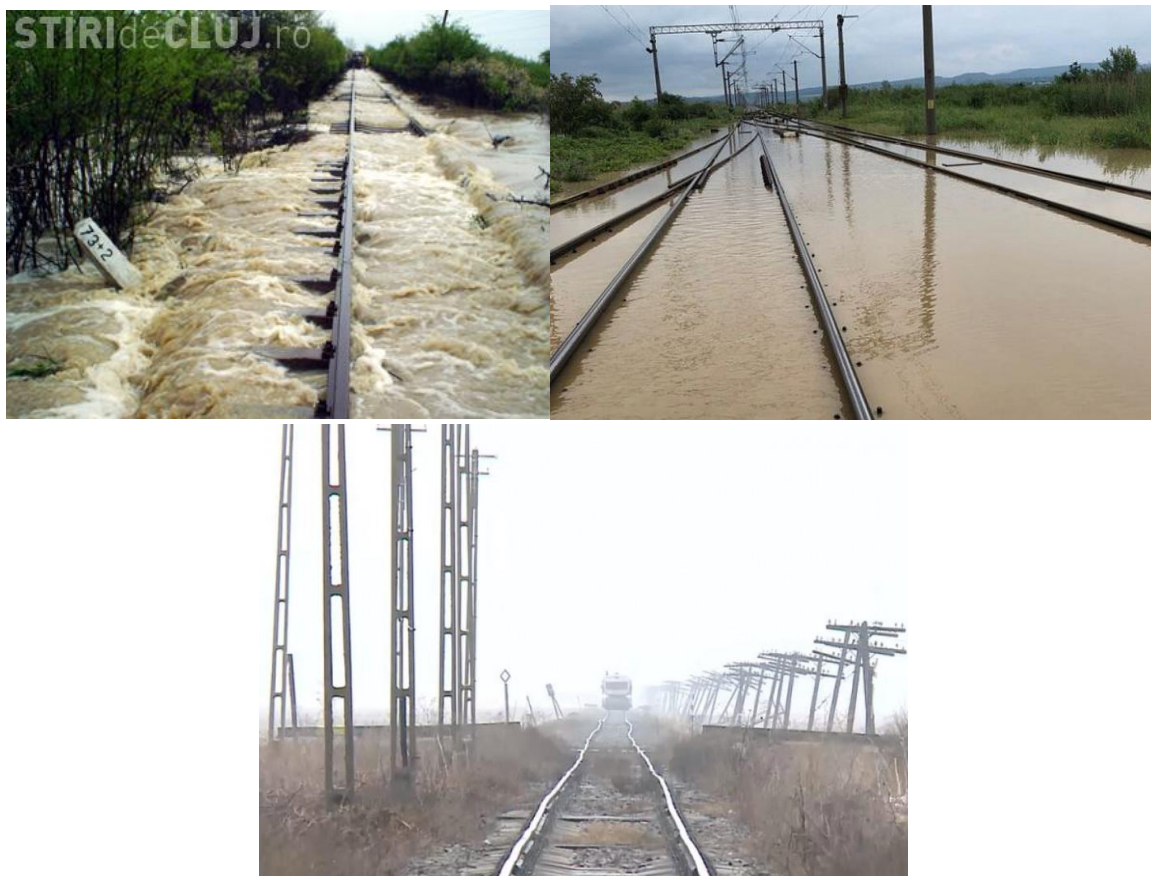
Figura nr. 7-1 Exemplul unui efect direct al schimbărilor climatice asupra unui aliniament de cale ferată (sursa: Stiridecluj.ro/Digi24)
