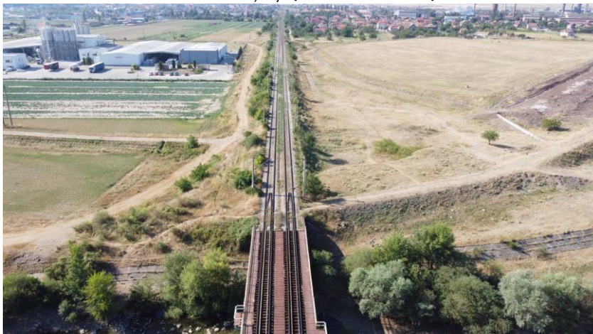
Vedere din dronă asupra CFR Coșlariu-Cluj Napoca în zona podului peste râul Arieș
