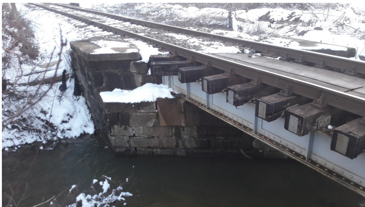
Figura 2: Pod 5÷10 m, km 462+081 (Anul de construcție 1932)
