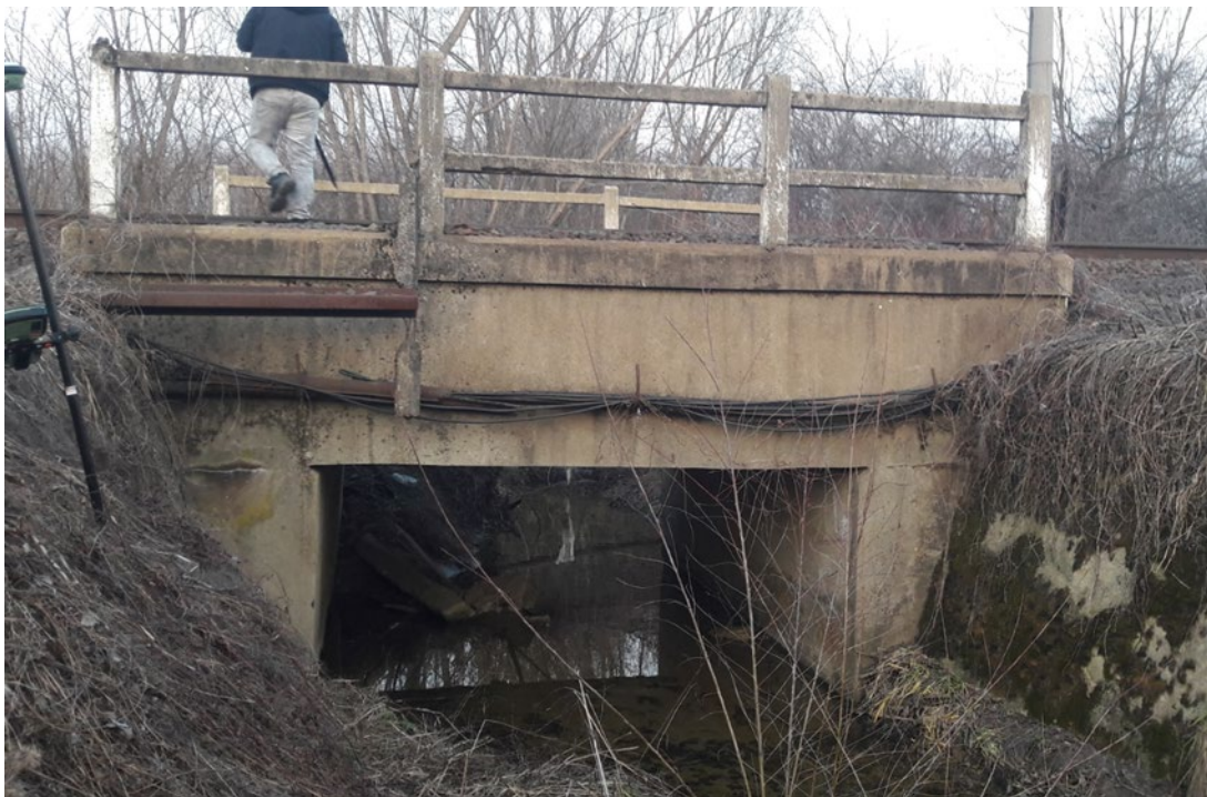
Figura 8: Podeț km 467+858 (Anul de construcție 1966)
