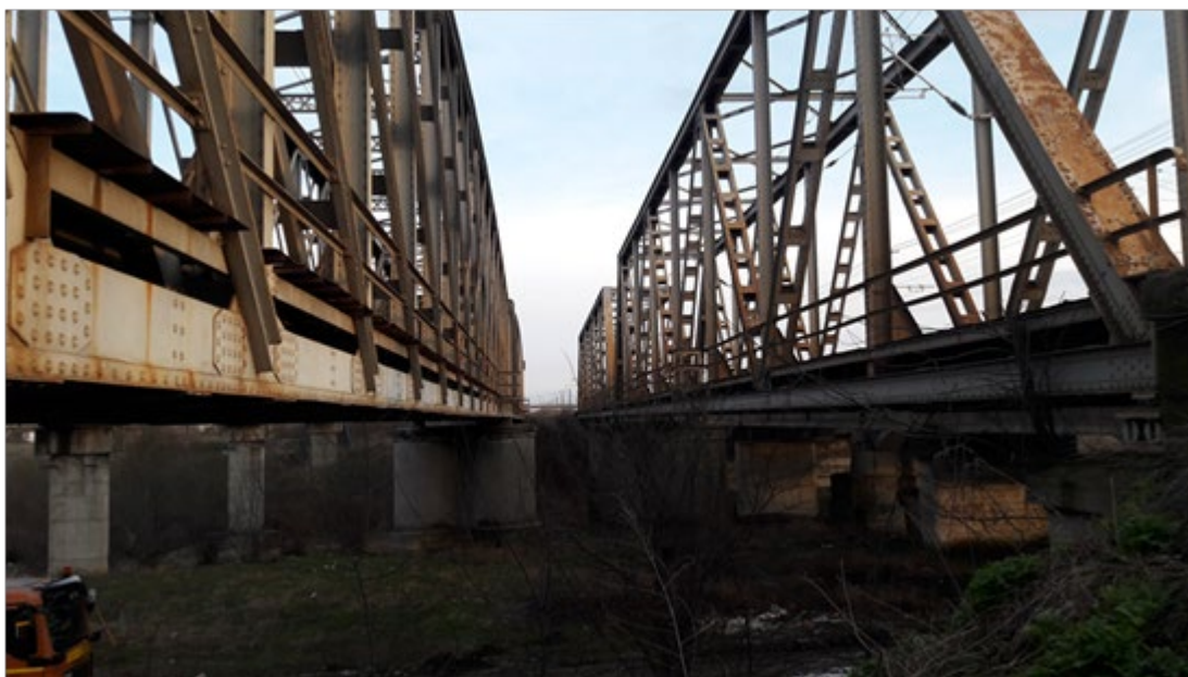
Figura 6: Pod L > 30 m, km 257+970 (Anul de construcție 1870, refăcut 1963)
