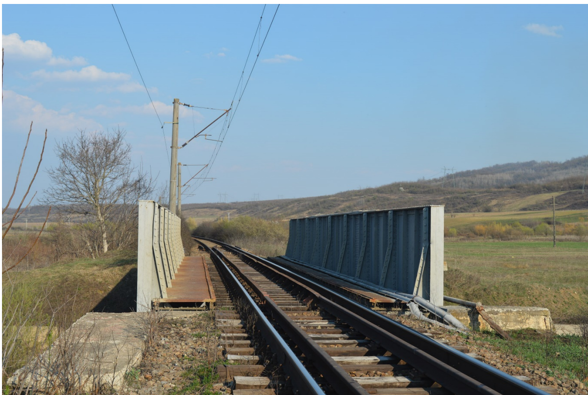
Figura 4: Pod 10 ÷ 30 m, km 314+217 (Anul de construcție 1873, refăcut 1957)
