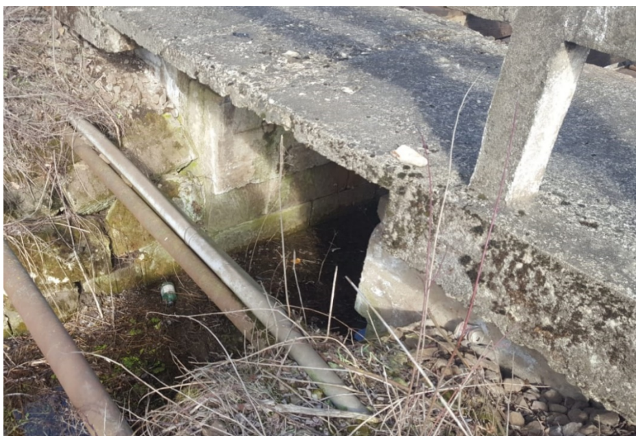
Figura 9: Podeț km 473+167 (Anul de construcție 1877, refăcut 1956)
