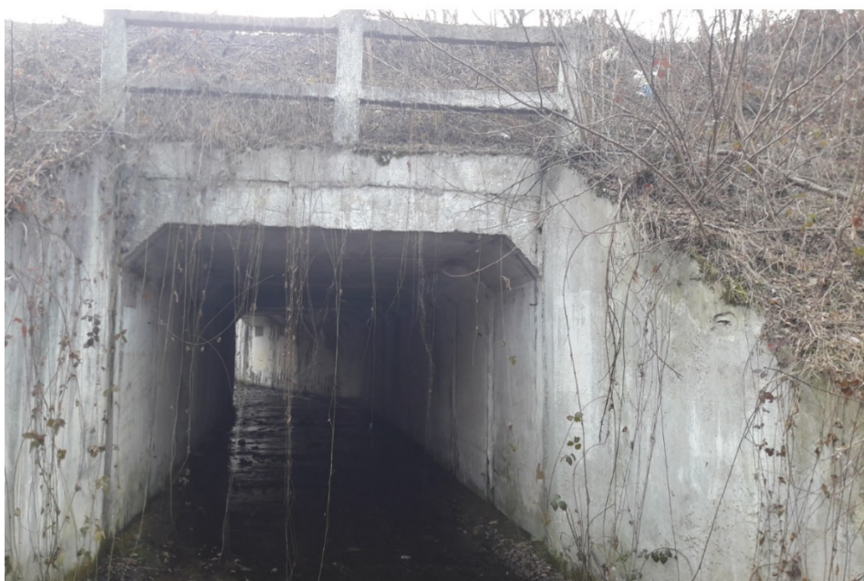
Figura 10: Podeț km 474+898 (Anul de construcție 1992)
