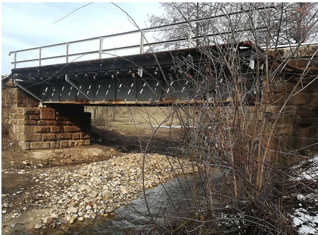
Figura 5: Pod 10 ÷ 30 m, km 459+350 (Anul de construcție 1931)
