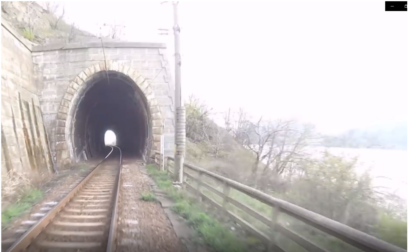
Figura 7: Tunel Virviorova existent
