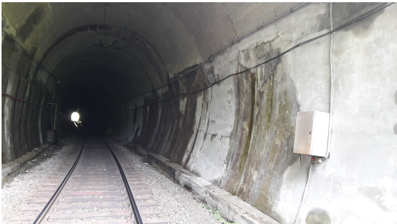
Figura 19: Vedere interioara Tunel Feneș
