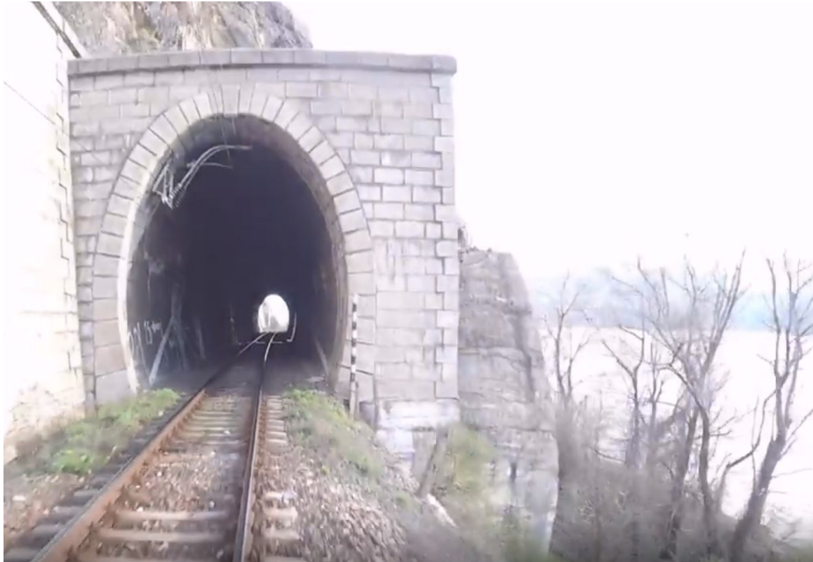
Figura 5: Tunel Vir existent
