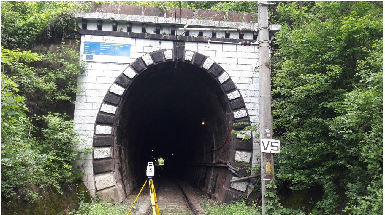
Figura 18: Vedere portal intrare Tunel Feneș
