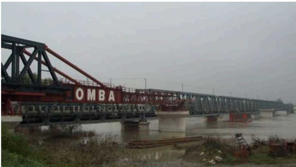
Figura 5: Exemplu de lansare prin împingere a tablierului de cale ferata in situatia de nivel ridicat al apelor ( raul Po Italia)
