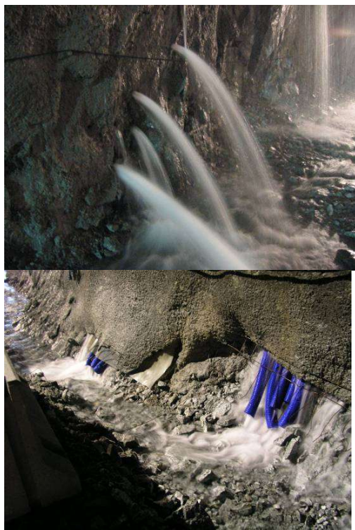
Photographs 3.5.a.- solutii Remediu pentru zone cu infiltratii mari.
