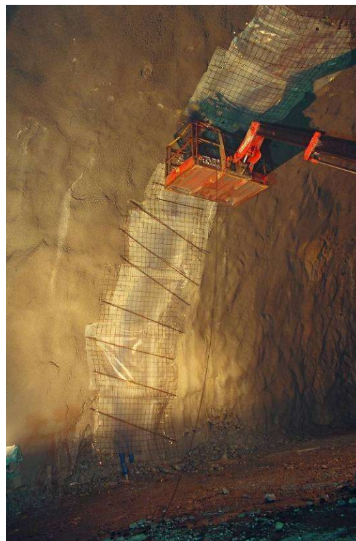
Photographs 3.5.a.- solutii Remediu pentru zone cu infiltratii mari.
