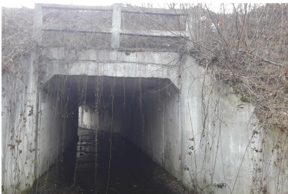
Figura 23: Poduț km 474+898 (Anul de construcție 1992)
