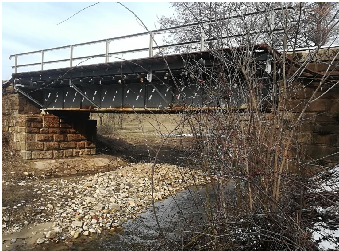
Figura 18: Pod 10 ÷ 30 m, km 459+350 (Anul de construcție 1931)
