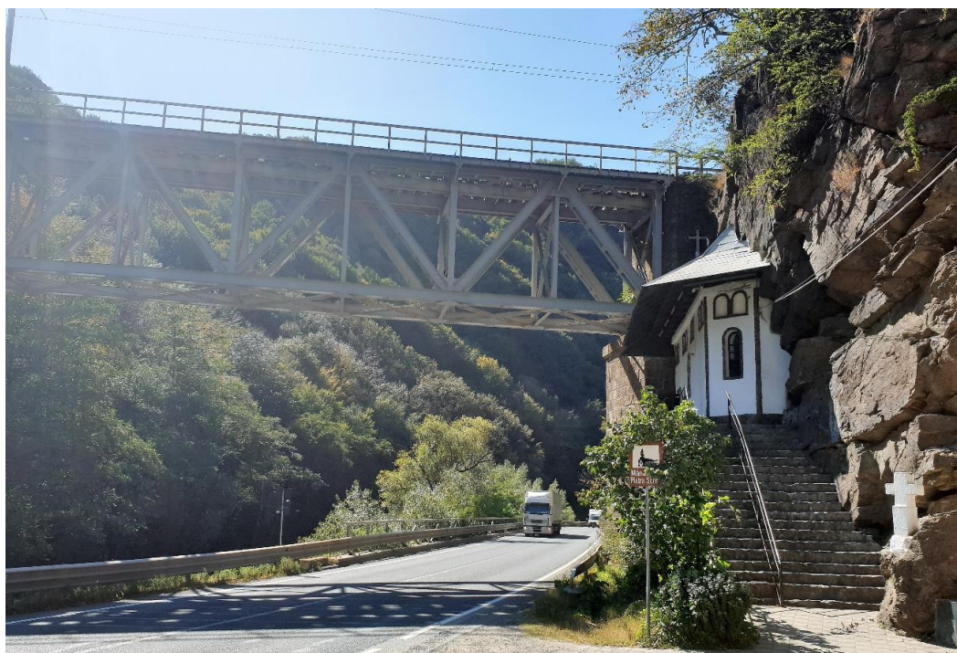
Poza 14 – Pod peste DN6 – km 450+855
