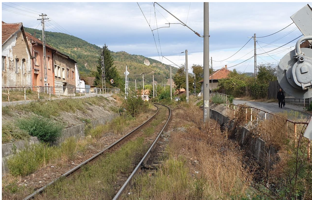
Poza 8 - •Linia de cale ferată prin zone locuite in Mehadia Veche– km ex. 410+460
