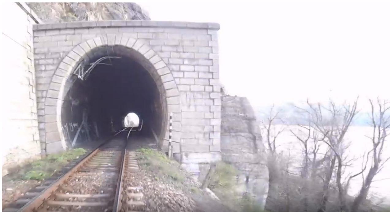
Figura 29: Tunel Vir existent
