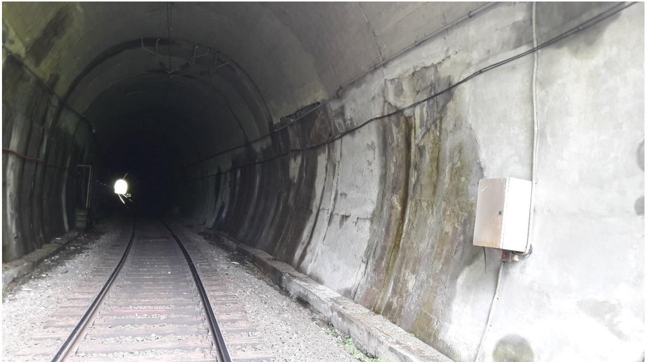
Figura 43: Vedere interioara Tunel Feneș
