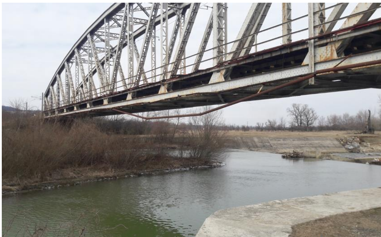
Figura 20: Pod L>30m, km 471+856 (Anul de construcție 1913)
