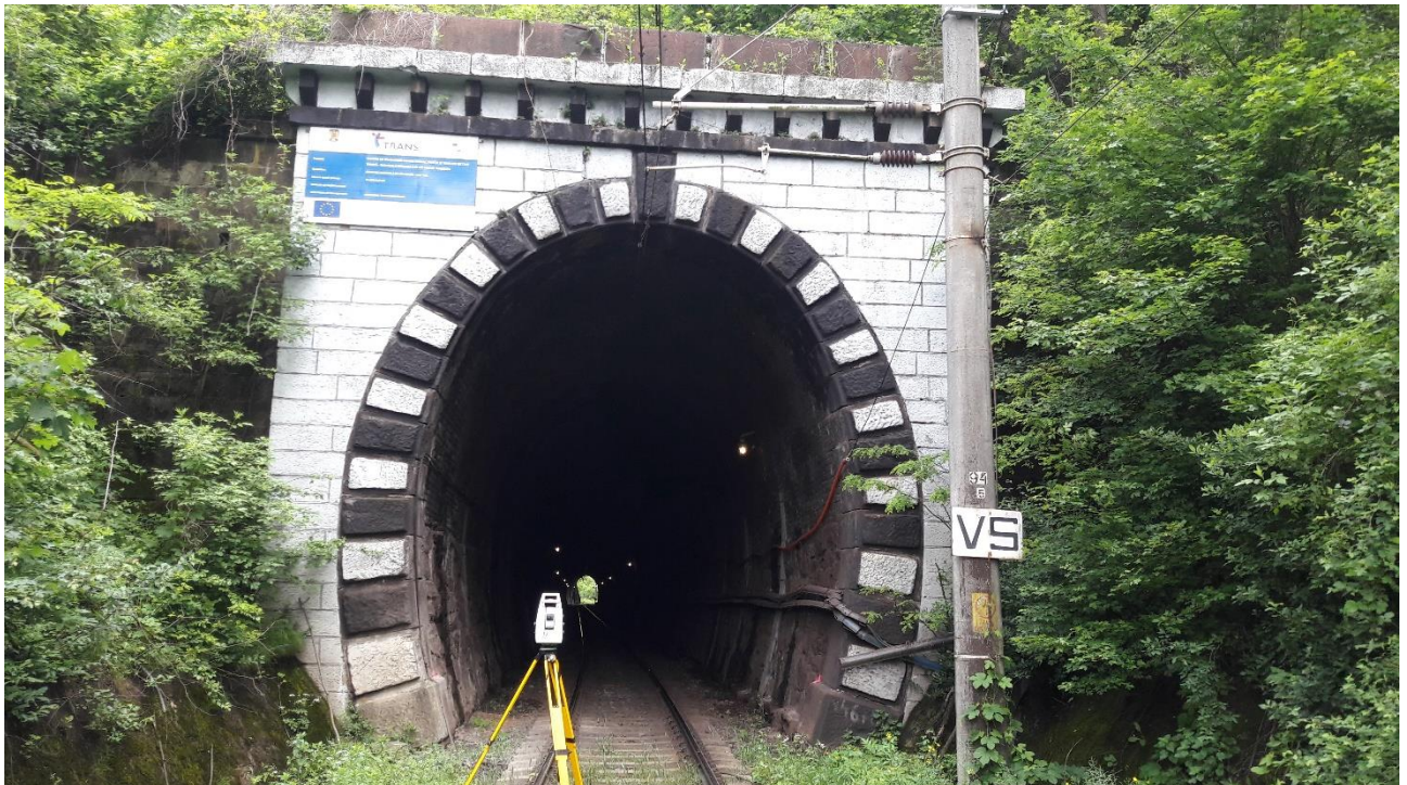
Figura 42: Vedere portal intrare Tunel Feneș
