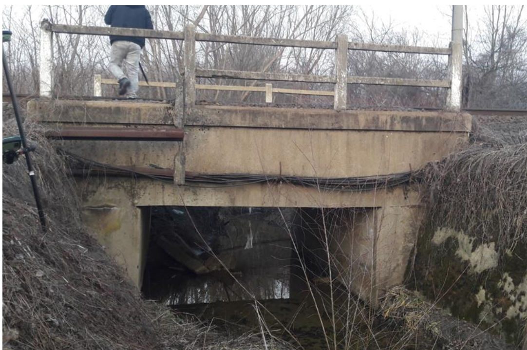
Figura 21: Podeț km 467+858 (Anul de construcție 1966)
