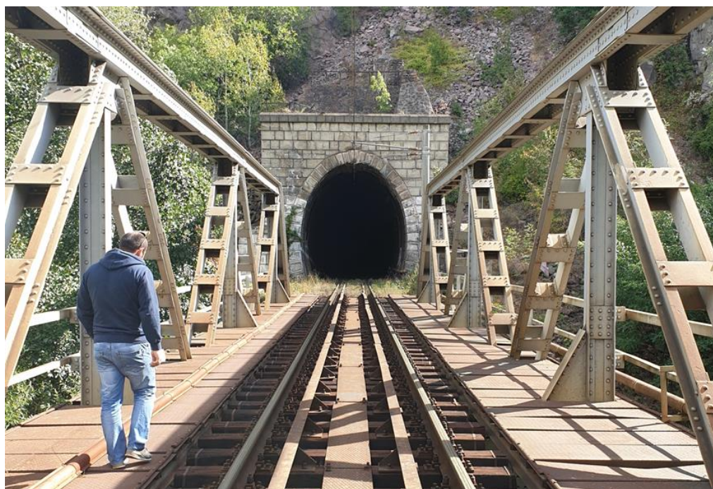
Poza 9 – Tunel Iablanita Nou si Pod– km ex. 413+840
