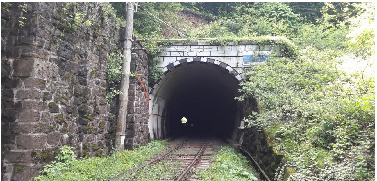
Figura 44: Vedere portal intrare Tunel Feneș spre Caransebeș
