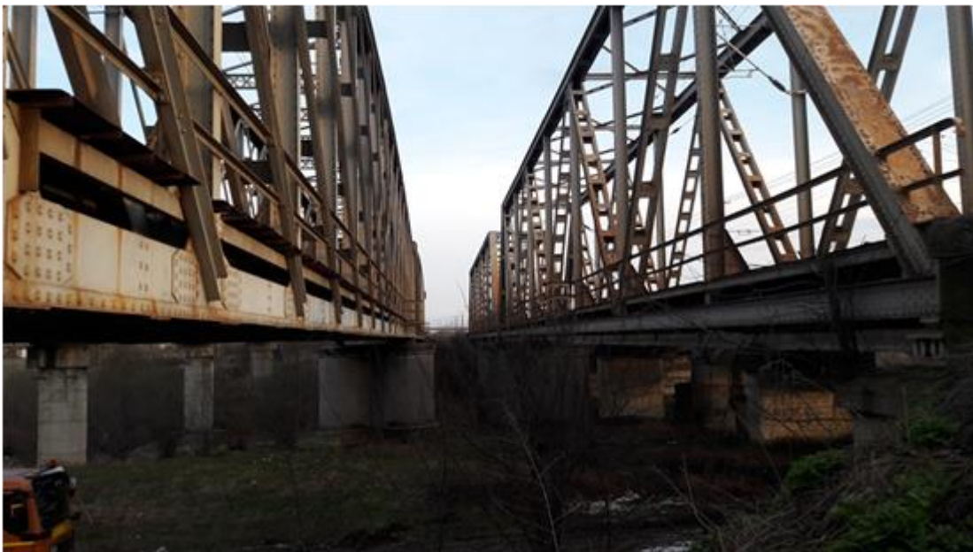
Figura 19: Pod L > 30 m, km 257+970 (Anul de construcție 1870, refăcut 1963)
