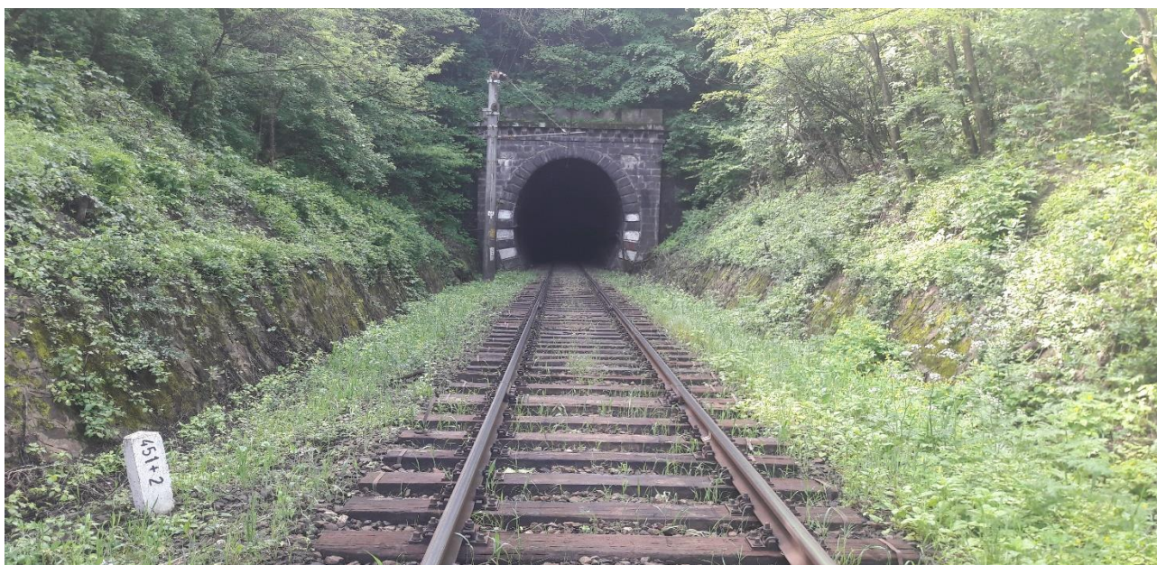
Figura 46: Vedere portal intrare Tunel Timpa
