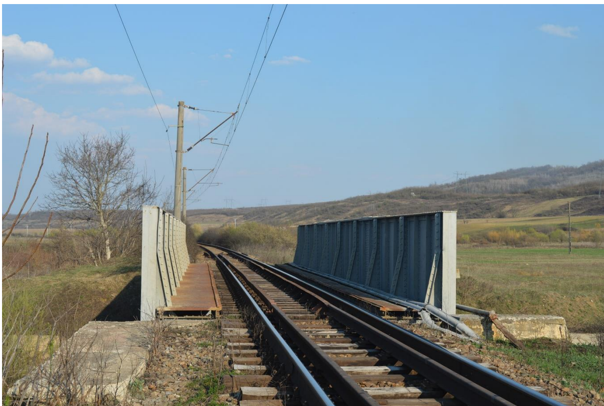
Figura 17: Pod 10 ÷ 30 m, km 314+217 (Anul de construcție 1873, refăcut 1957)
