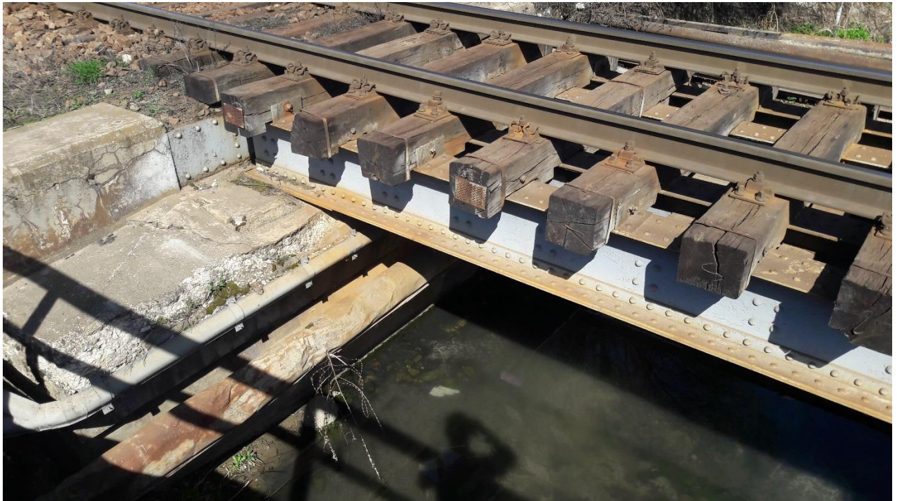
Figura 16: Pod 5÷10 m, km 286+542 (Anul de construcție 1970)
