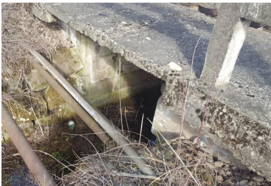
Figura 22: Poduț km 473+167 (Anul de construcție 1877, refăcut 1956)
