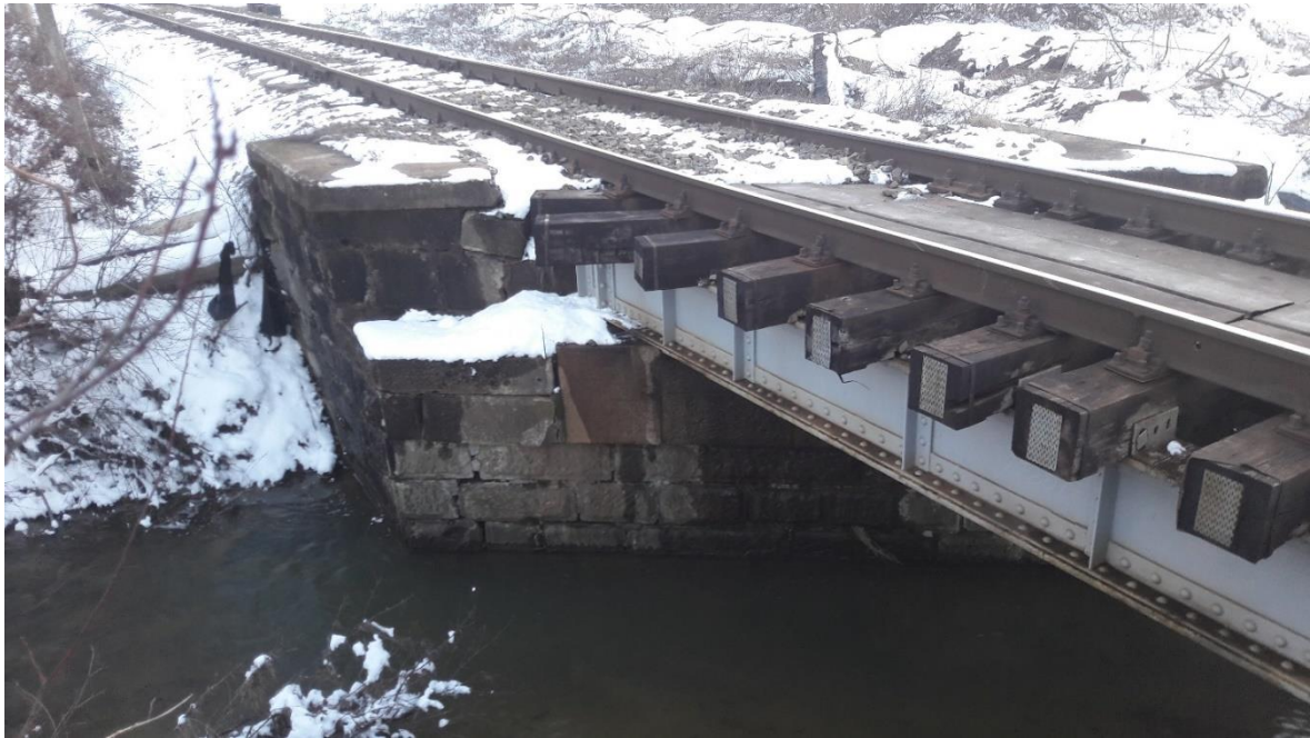
Figura 15: Pod 5÷10 m, km 462+081 (Anul de construcție 1932)
