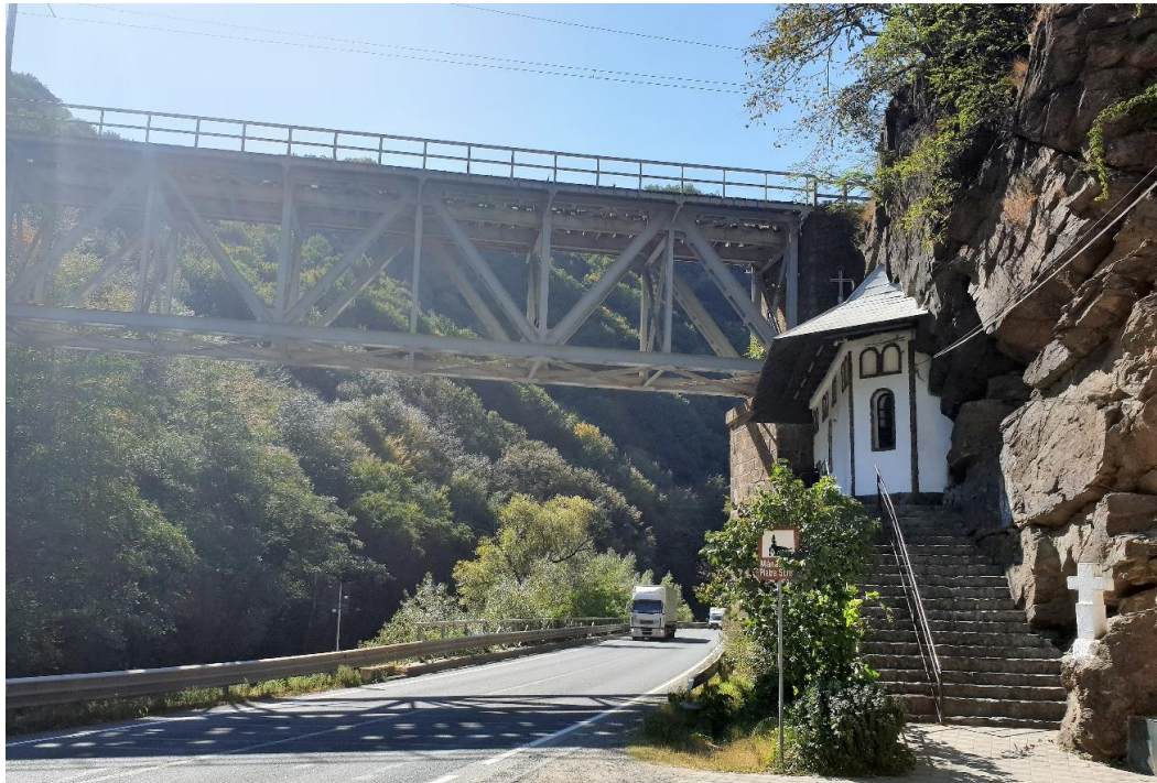
Poza 14 – Pod peste DN6 – km 450+855
