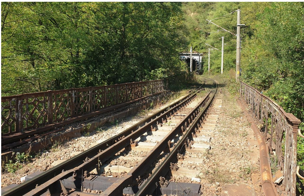
Poza 13 - Pod peste DN6 si Tunel Fenes – km ex. 446+808
