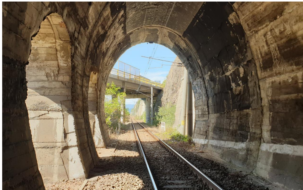
Poza 3 – Tunel Mosu și DN6 Pasaj Superior – km ex. 375+300
