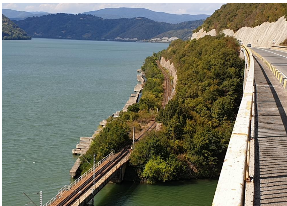
Poza 15 – Tronson unde a fost prevăzută Varianta nr. 5 de traseu – km ex. 378+500
