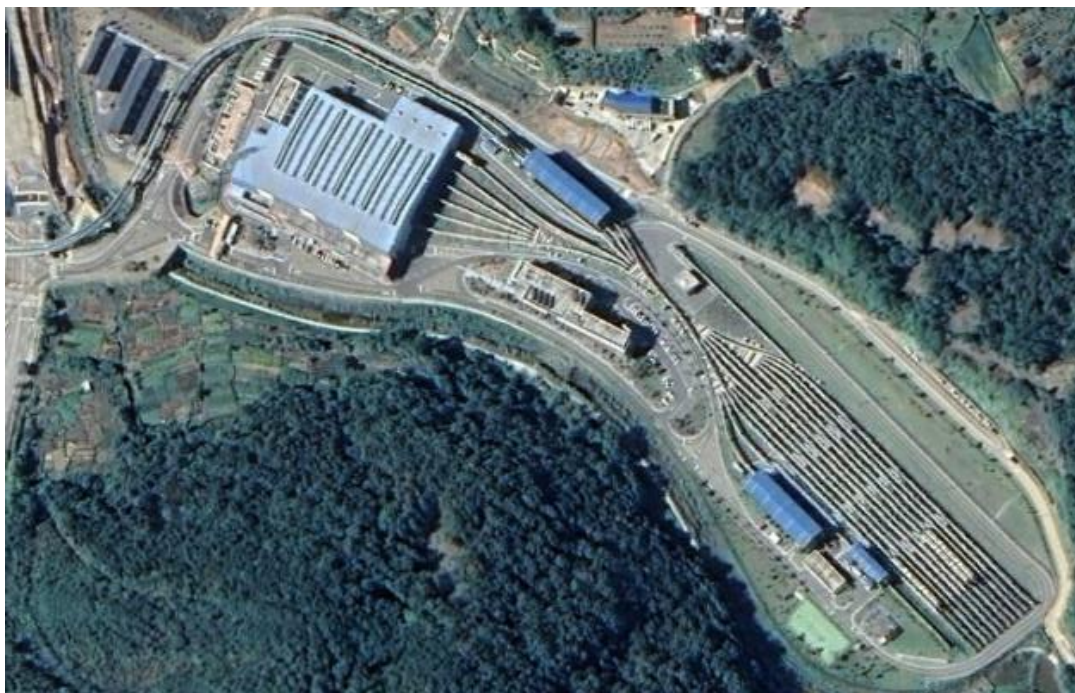
Figura 3.2-25. Vedere aeriană a amenajării unui depou monorail în Daegu, Coreea de Sud (sursă Google Earth)
