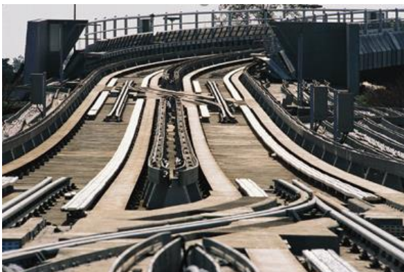
Figura 3.2-18. Schemă detaliu al macazului pentru VAL
