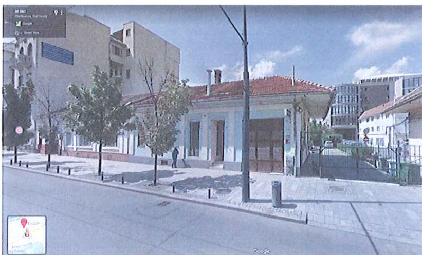
Figura 5.3-119. Amplasament și vedere imobil situat pe Calea Moților nr. 64
