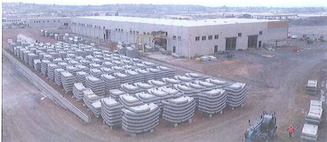
Figura 5.3-51. Zona de depozitare a segmentelor prefabricate de inel.
