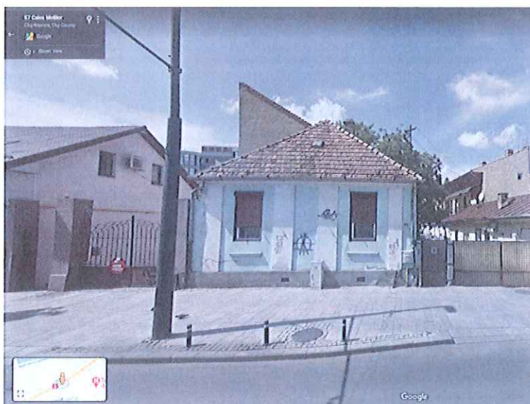
Figura 5.3-122. Amplasament și vedere imobil situat pe Calea Moșilor nr. 56-58, clădire vest
