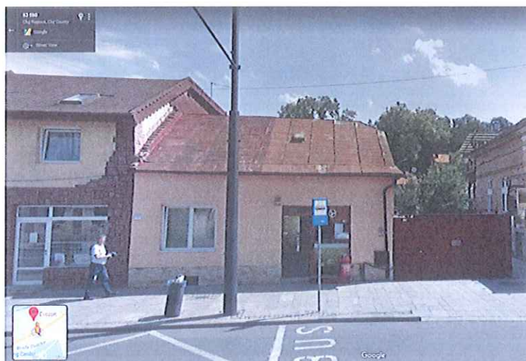
Figura 5.3-120. Amplasament și vedere imobil situat pe Calea Moților nr. 63
