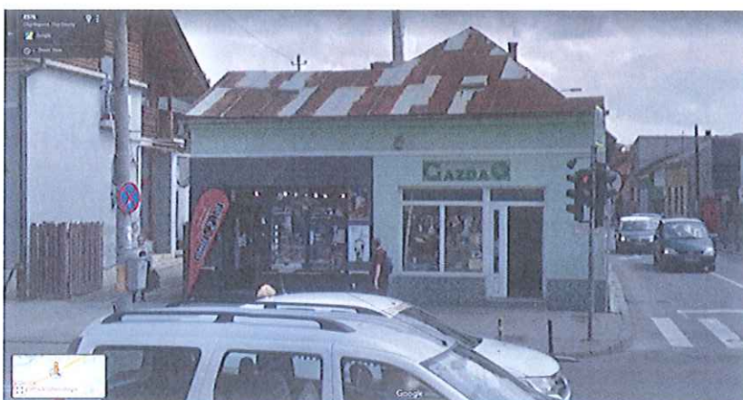
Figura 5.3-126. Amplasament și vedere imobil situat pe B-dul 21 Decembrie 1989 nr. 116, clădire vest
