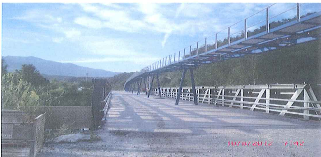
Figura 5.3-54. Transportor cu bandă pentru material excavat în afara tunelului
