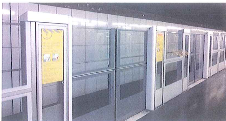
Figura 5.3-135. Porți automate pentru peron, Paris Metro RATP
