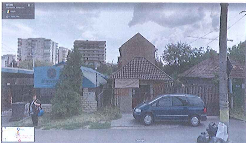
Figura 5.3-129. Amplasament și vedere imobil situat pe Str. Teodor Mihali nr. 11
