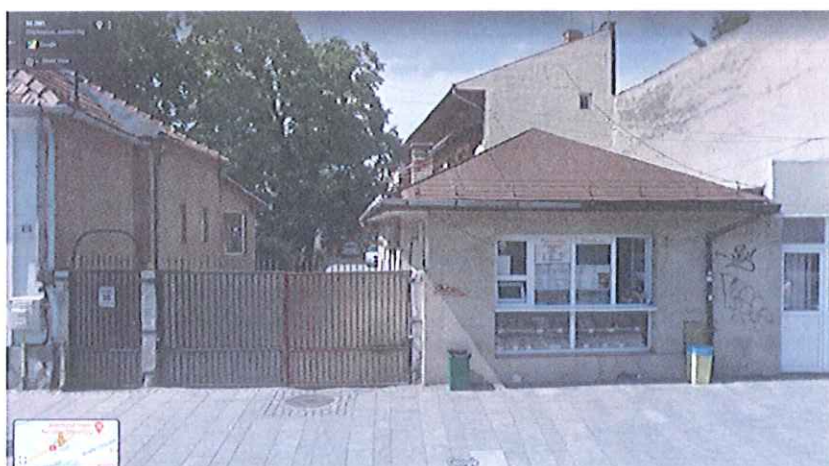
Figura 5.3-123. Amplasament și vedere imobil situat pe Calea Moților nr. 56-58, clădire est
