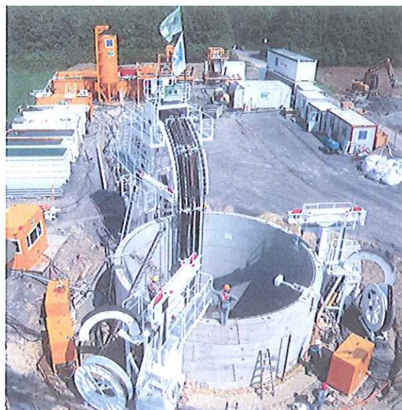
Figura 5.3-75. Santier tipic pentru VSM
