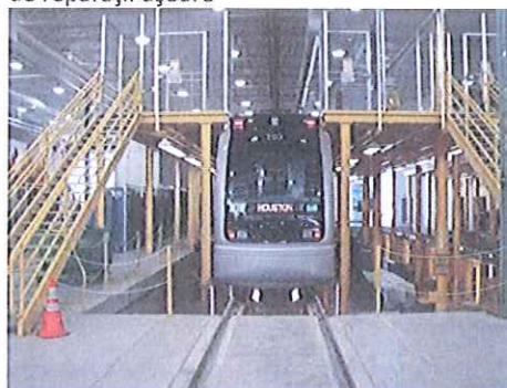
Figura 5.3-153. Exemplu de pasarele fixe laterale
