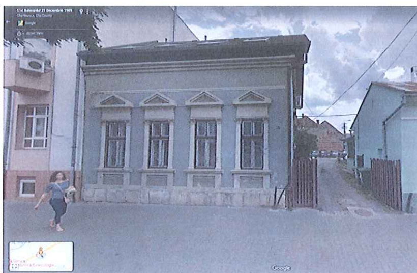
Figura 5.3-127. Amplasament și vedere imobil situat pe B-dul 21 Decembrie 1989 nr. 116, clădire est
