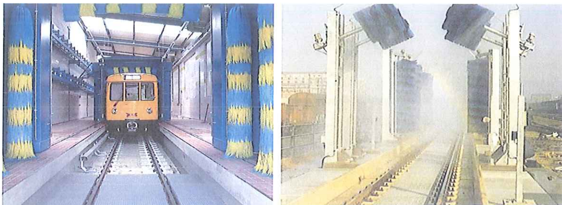
Figura 5.3-149. Exemple de stații de spălare automatizate
