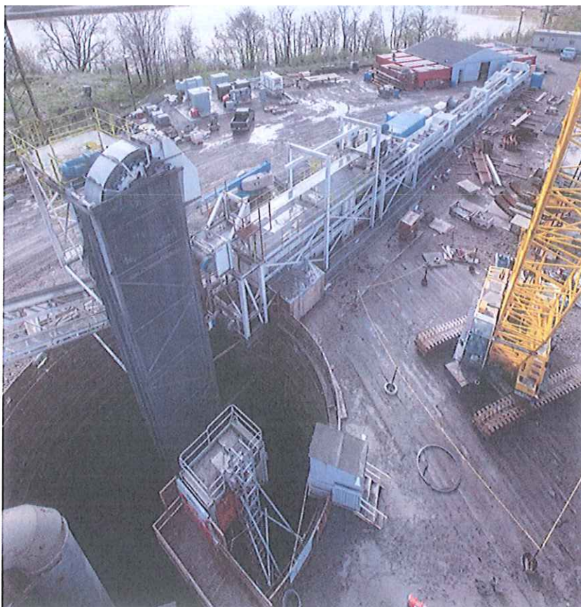
Figura 5.3-56. Transportor cu bandă verticală pentru materialul excavat dintr-un put vertical
