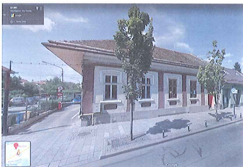
Figura 5.3-121. Amplasament și vedere imobil situat pe Calea Moților nr. 62
