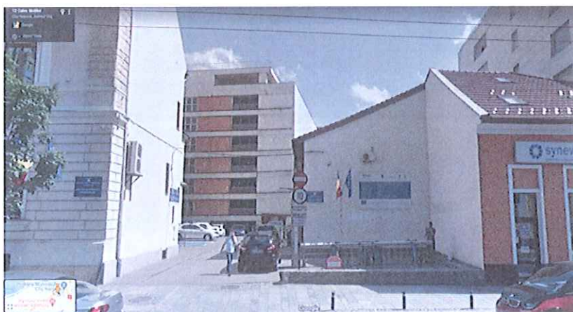
Figura 5.3-125. Amplasament și vedere imobil situat pe Calea Moților nr. 5
