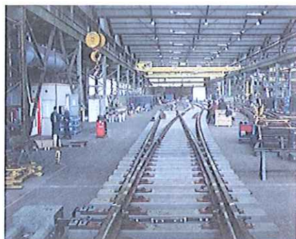
Figura 5.3-166. Exemplu de amenajare interioară a unui Atelier de Reparații Infrastructură
