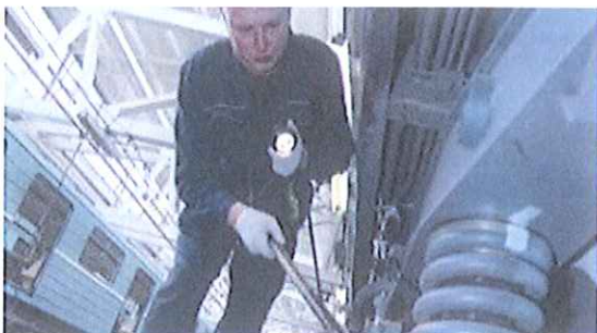
Figura 5.3-146. Exemplu de operațiune de mentenanță ușoară : inspecție a organelor de rulare
