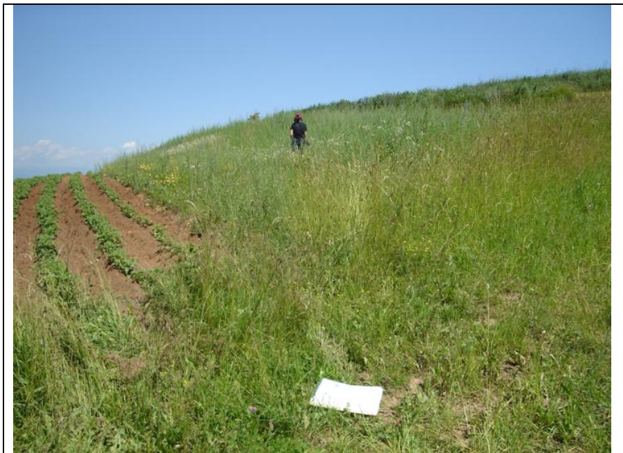
Foto 5 : Vedere km 3+520 spre km 3+600 – traseu in urcare pe deal
