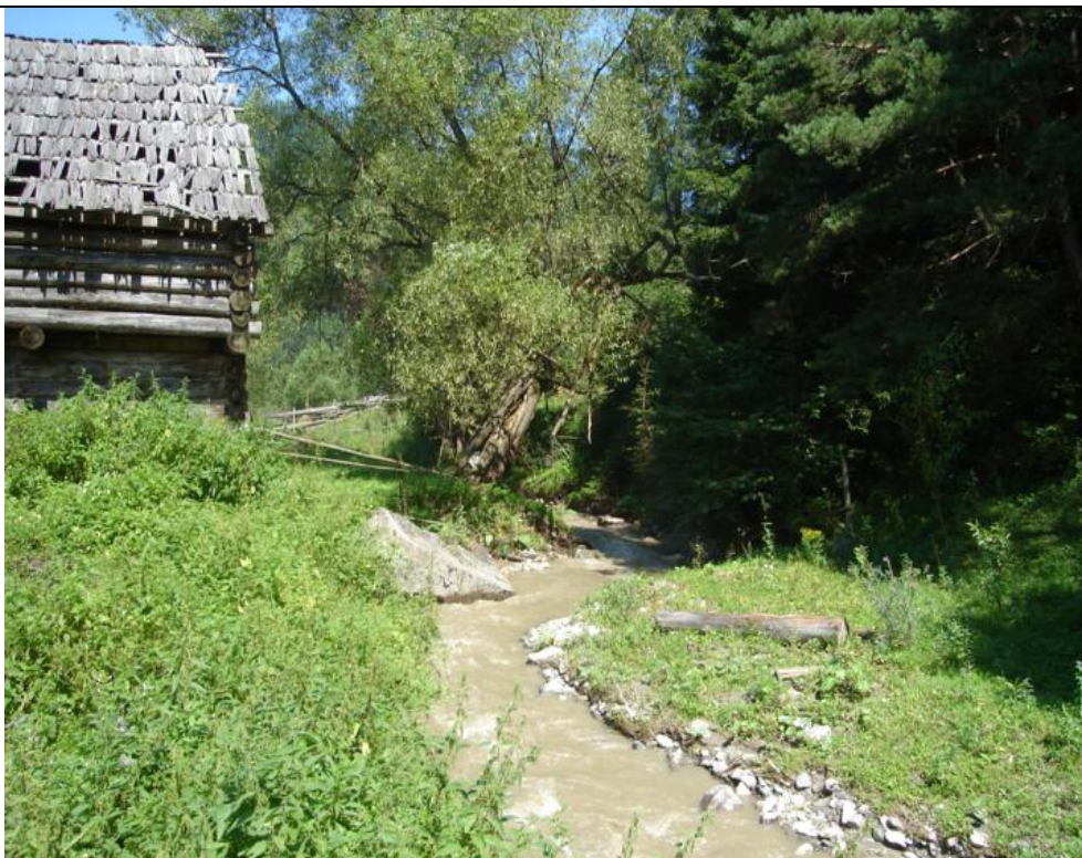
Foto 31 : Traversare paraul Sumuleu, vedere din amonte
