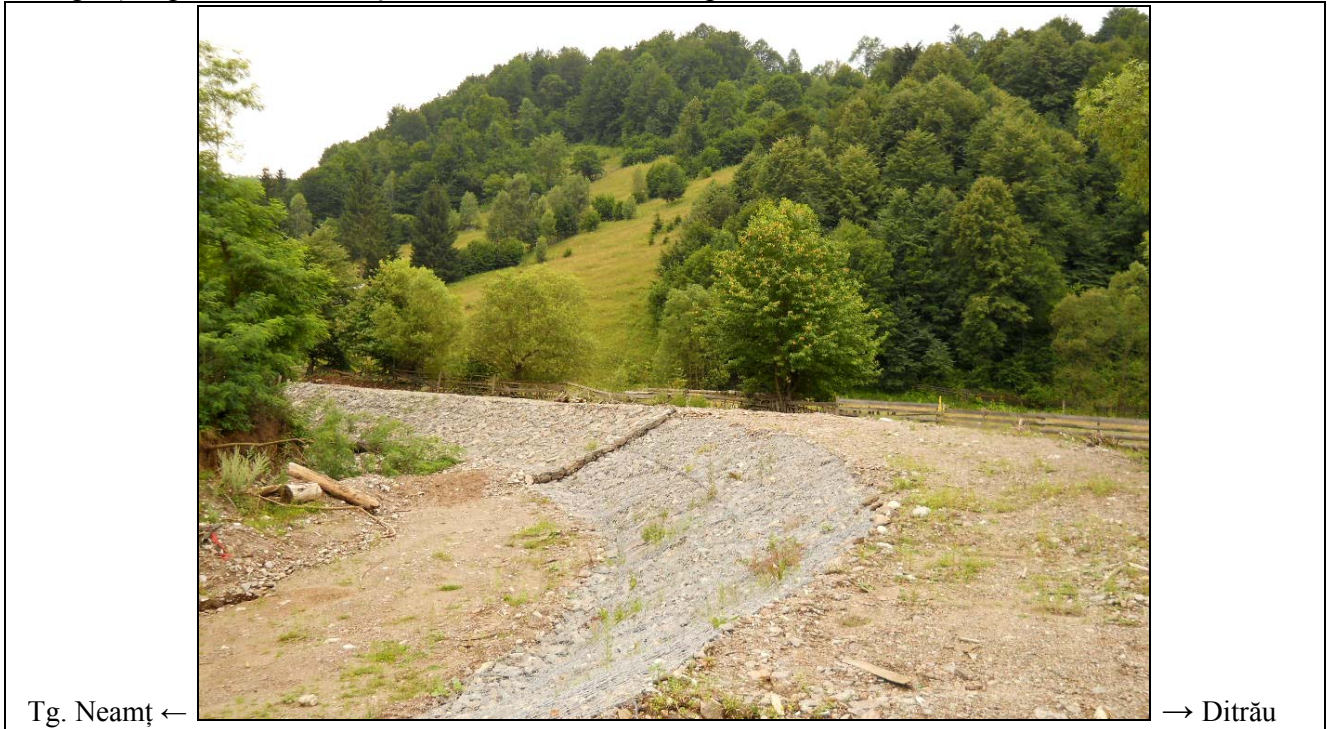
Foto34: Detaliu din ampriza traseului autostrăzii – km 36+300 spre cursul regularizat (mal drept îndiguit) al pârâului Văraia și versantul amonte - dreapta;
