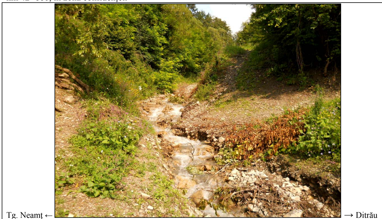
Foto 60: Detaliu traversare traseu proiectat peste Pârâul Luncilor (afluent dreapta al Bistricioarei) – km 42+660, în zona confluentei.
