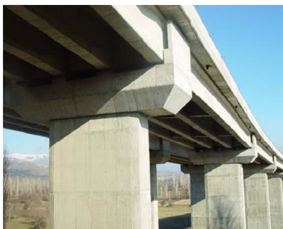
Fig 7. Structura cu grinda din beton precomprimat cu sectiune transversala variabila in forma „I” (tip F)
