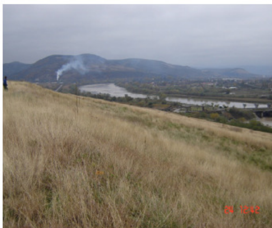
Vedere de sus a depozitului de cenusa
