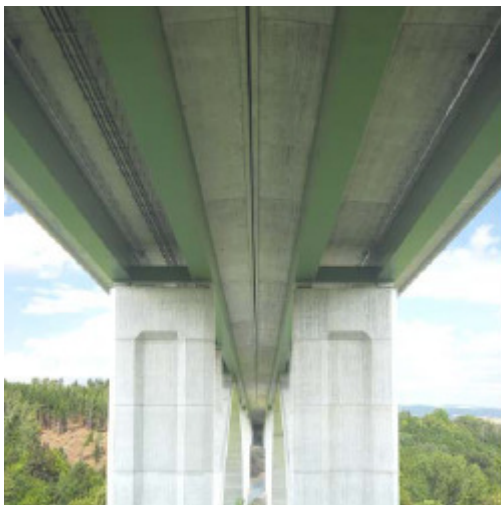
Fig 2. Structura compusa cu grinzi casetate gemene de dimensiuni mici (tip A)
