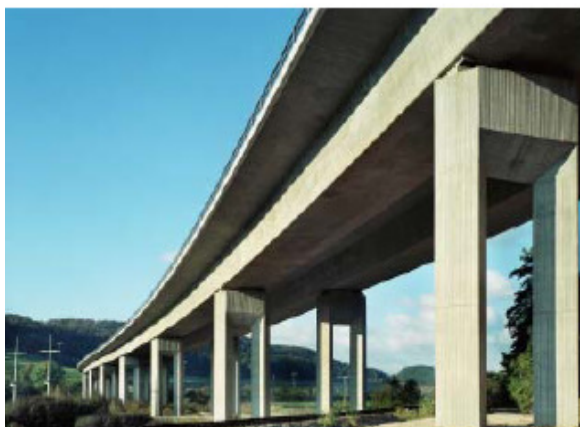
Fig 6. Structura din beton precomprimat compusa cu grinda casetata simpla (tip E)
