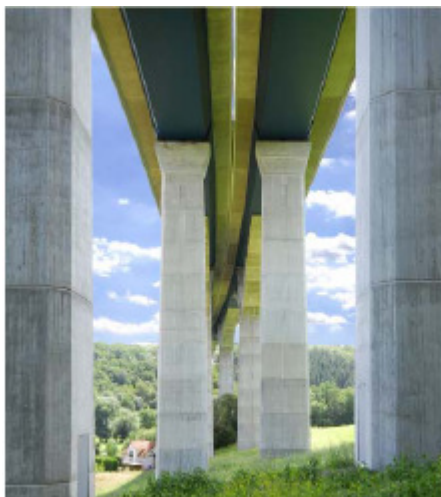
Fig 3. Structura compusa cu grinda casetate simpla (tip B)
