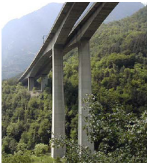
Fig 4. Structura din beton precomprinat compusa cu grinda casetate simpla ridicata prin metoda executiei in consola (tip C)
