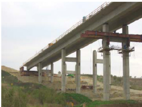
Fig 5. Structura din beton precomprinat compusa cu grinzi gemene in forma de T (tip D)
