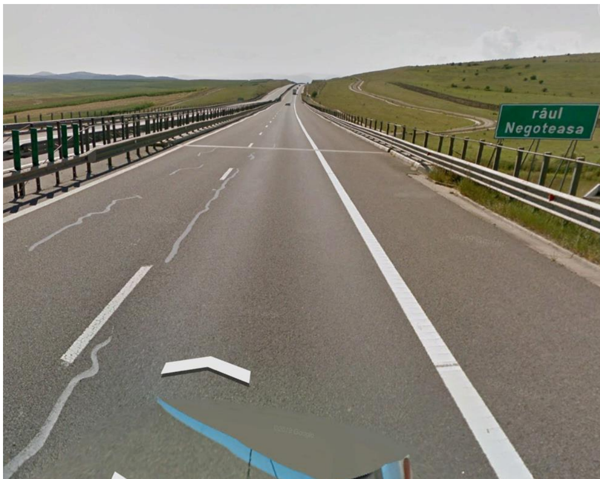
Figura 93 Exemplu de pe autostrada A3 km 22 traversare viaduct peste Raul Negroteasa.
