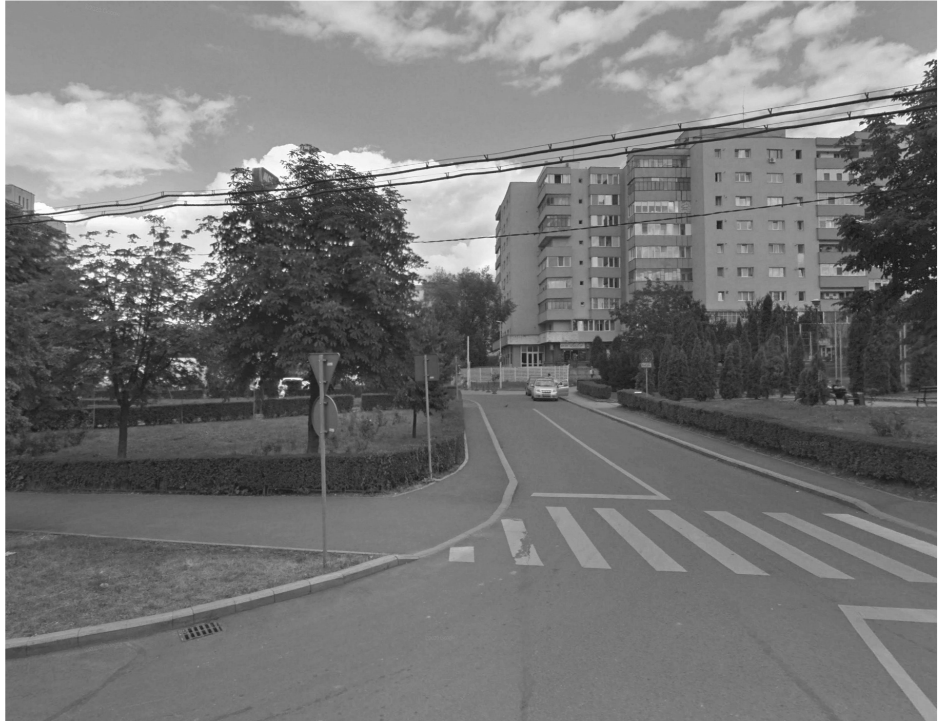
Tronson strada Almașului propus pentru eliminare
