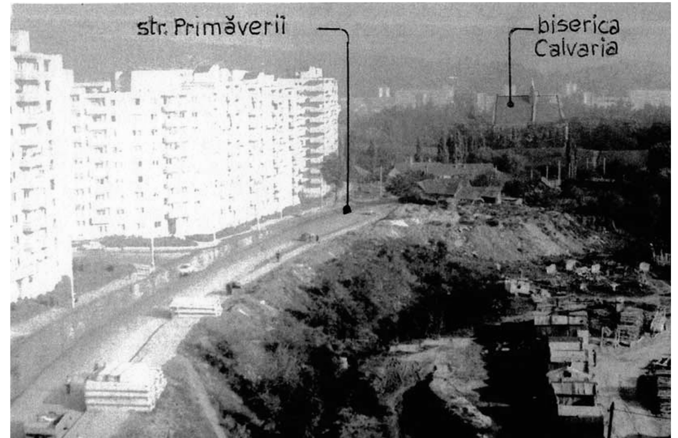
Vedere către Biserica Calvaria și str. Primăverii - Pârâul Calvaria necanalizat 1973 sursă fotografie: Mitrea, Vasile. Cluj-Napoca în proiecte 50 ani 1960-2010 , Cluj Napoca: Casa cărții de știință, 2016, p.32
