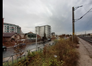
lipsă îngrijire adecvată cale ferată, vegetație ruderală și invazivă
