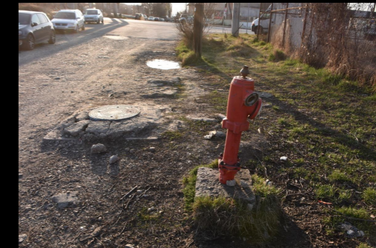
un hidrant stradal local - str Câmpul Pâinii lângă barieră
