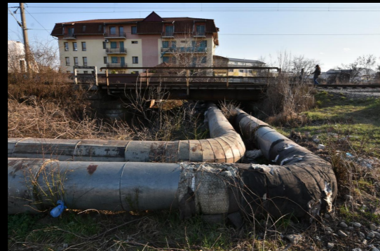
traversare sub calea ferată parazitând Canalul Morii
