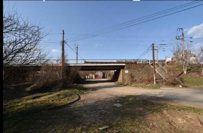
capătul vestic al străzii Rășăritului cu podul feroviar cuplat cu pasaje laterale de subtraversare carosabile la est și la vest de râu
