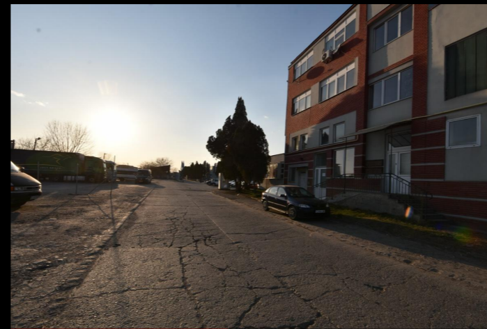
strada Câmpul Pâinii către platforma Sanex
