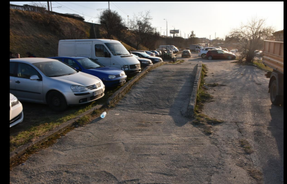
platforme reziduale strada Hunedoarei - pod IRA
