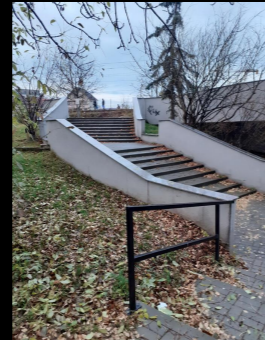
segmente de trasee pietonale aferente pasajului de pe strada Fabricii, amenajare coerentă din anii '70 cu probleme de mentenanță și de accesibilitate pentru persoane cu dizabilități
