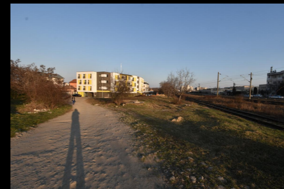
racordarea subtraversării podului IRA cu strada Ghimeșului
