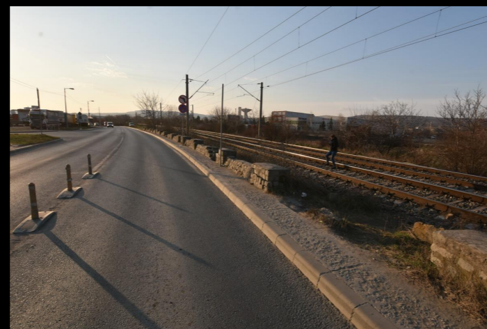
zona podului IRA_prospect neadecvat, lipsă trotuar și îngrădire cale ferată
