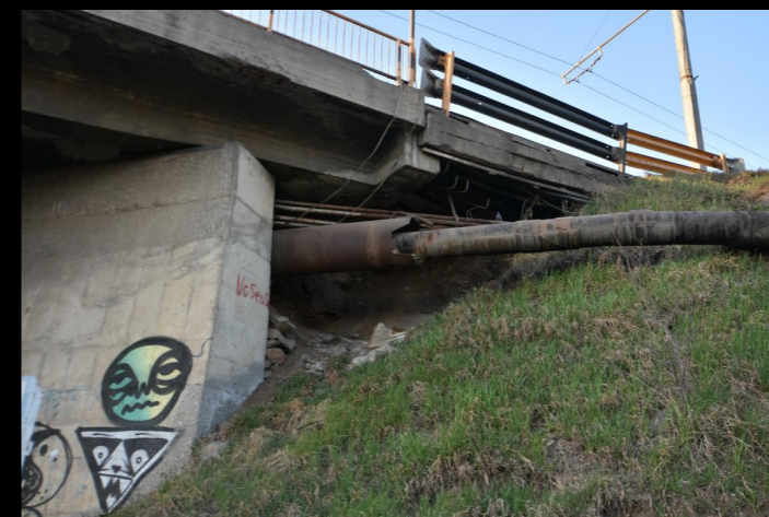
stare tehnică pod IRA latura nord-est
