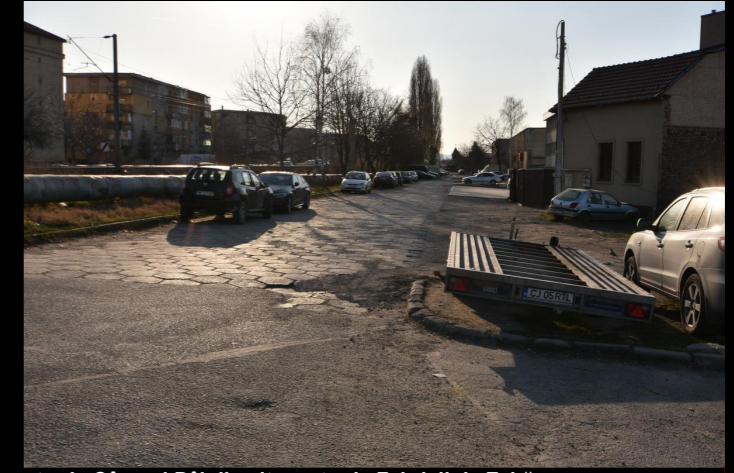
strada Câmpul Pâinii colț cu strada Fabricii de Zahăr
