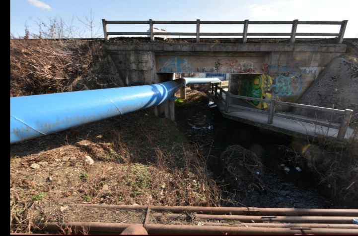
Canalul Morii la subtraversarea căii ferate în dreptul platformei Clujana
