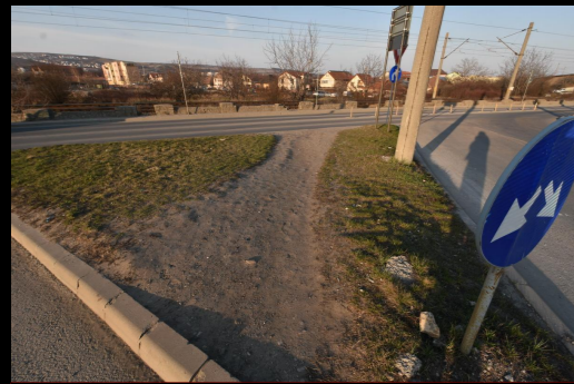
segmente de trasee pietonale aferente pasajului de pe strada Fabricii, amenajare coerentă din anii '70 cu probleme de mentenanță și de accesibilitate pentru persoane cu dizabilități
