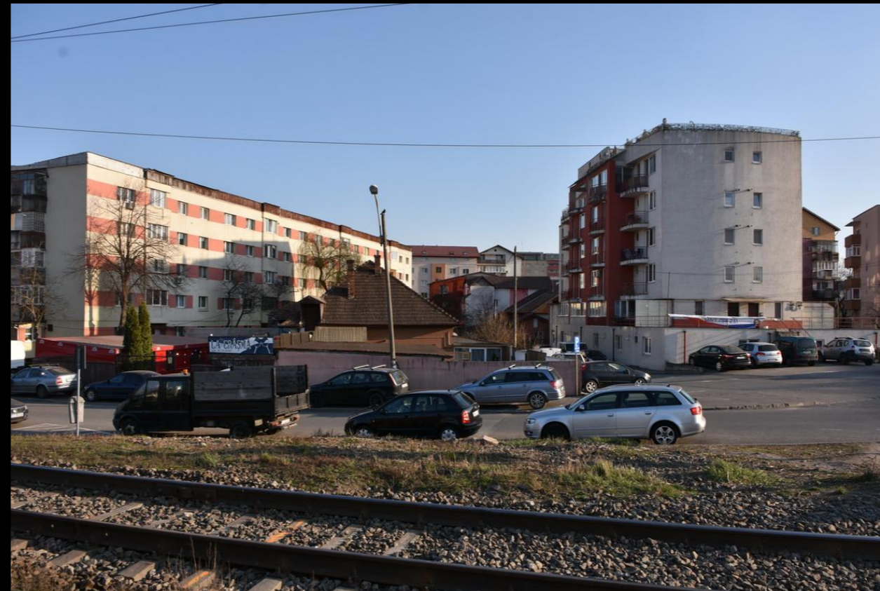
zonă urbană distrusă la intersecția str. Răsăritului - str. Tribununu Vlăduțiu
