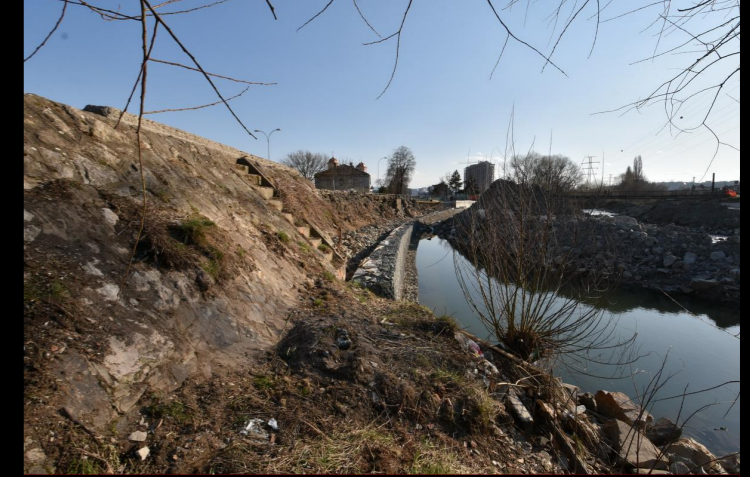
malul drept al Someșului Mic, capătul străzii Rășăritului - șantier pod
