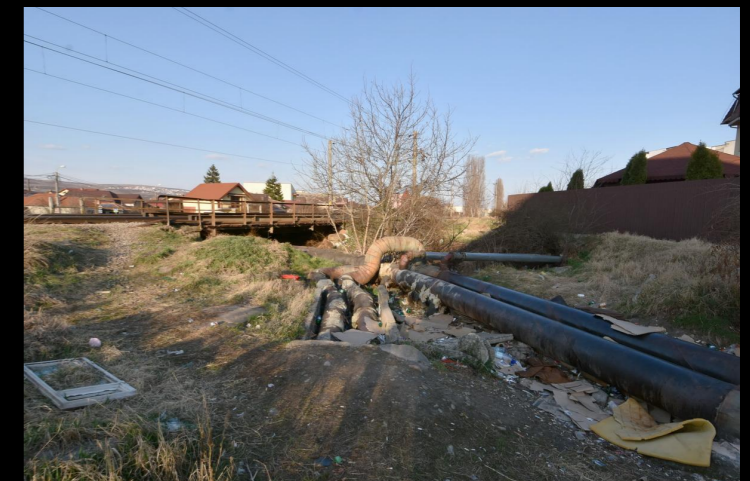
pod feroviar peste Canalul Morii - braț estic dezafectat
