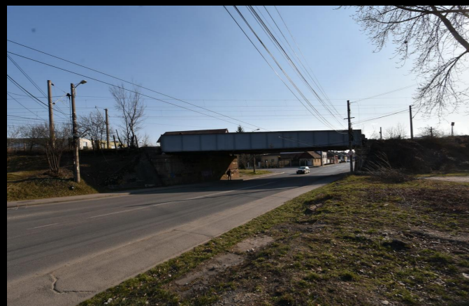
Piața 1 Mai, pod feroviar cu subtraversarea căii ferate a străzii Paris
