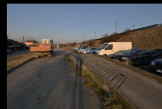
zona adiacentă str. Hunedoarei
