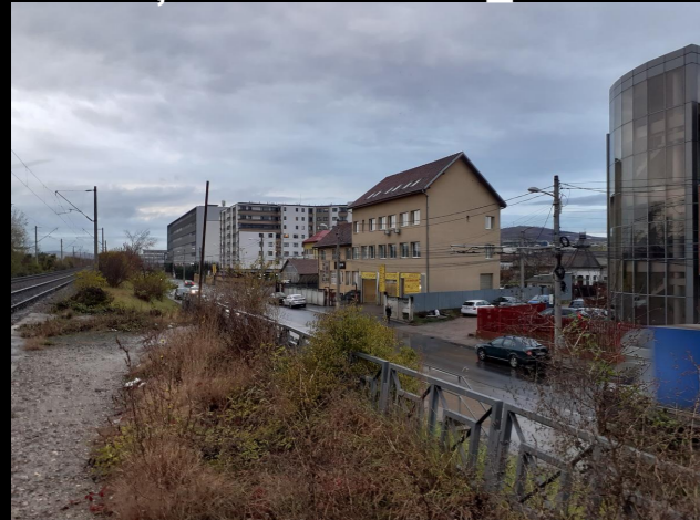
halta Clujana cu amenajări neadecvate și lipsa de mentenanță
