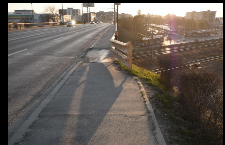
starea tehnică pod IRA_obstacole, îngustare, lipsă protecție adecvată
