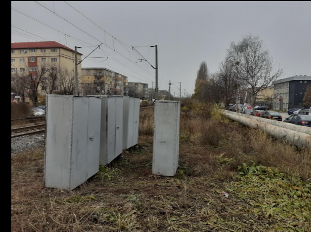
infrastructura feroviară are o sumedenie de elemente în peisaj și nu dispune de măsuri de protecție (fonic și la treceri)
