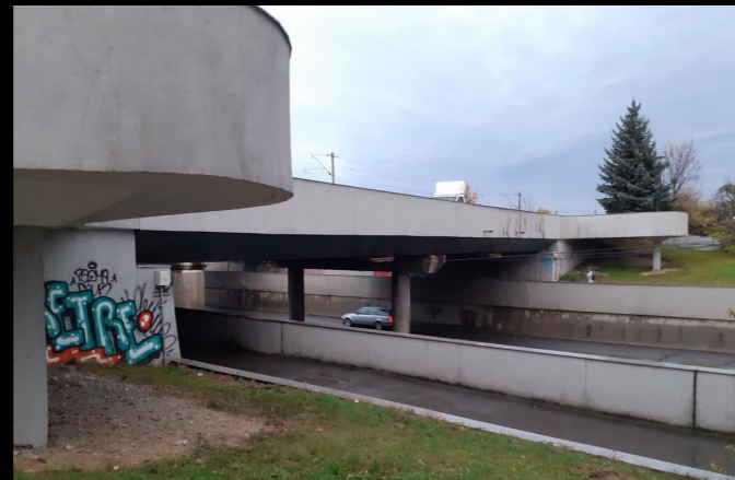
pod triplu carosabil-feroviar-carosabil_subtraversare străzii Fabricii
