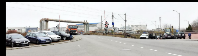
strada Fabricii de Zahăr trecere la nivel cu calea ferată facilitată de barieră
