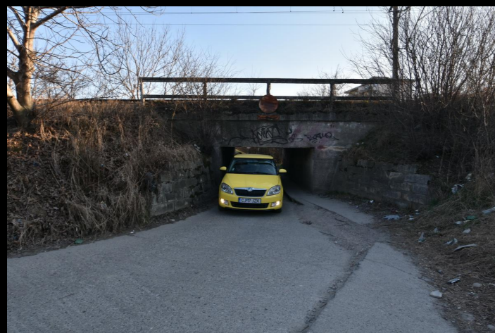
pasaj inadecvat în dreptul platformei Sanex
